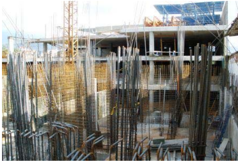
Fotografía 1. Obra Torre Miró
