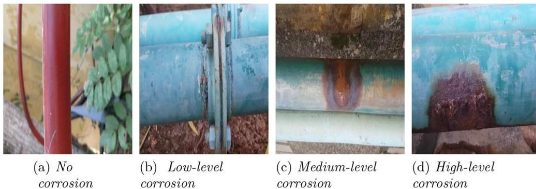
**Figura 2** Corrosión detectada por inspección visual en diferentes grados de afectación. Tomado de: Bastian et al. (2019) Visual inspection and characterization of external corrosion in pipelines using deep neural network.
