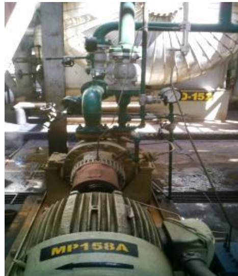
Figura 59. Equipo SP158C con Plan API 11/62.
