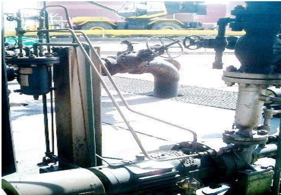
Figura 33. Ejemplo Plan API 21.
