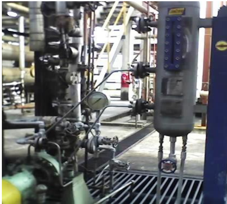
Figura 40. Ejemplo plan 52.
