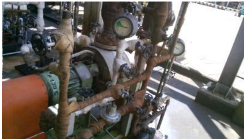
Figura 62: Plan API 11/62 del equipo SP139C
