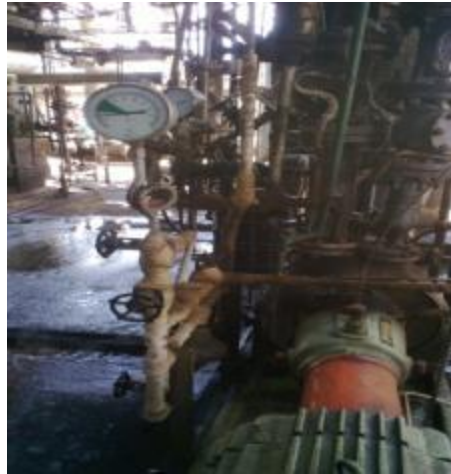
Figura 63: Plan API 32/62 del equipo SP137C.
