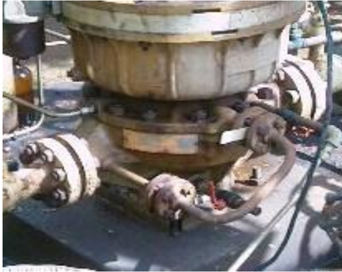
Figura 30. Ejemplo del Plan 13
