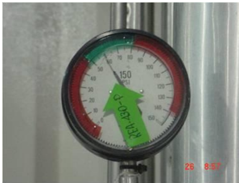
Figura 71. Ejemplo de rangos de operación en indicadores de presión.
