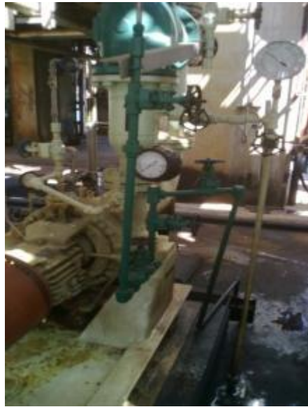
Figura 57. Equipo SP165A con Plan API 11/62.
