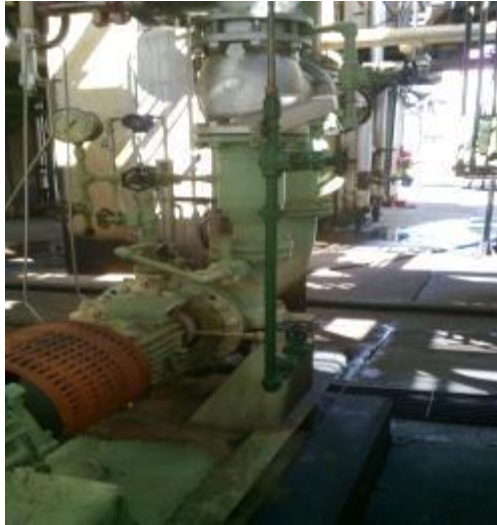
Figura 58. Equipo SP151C con Plan API 11/62.
