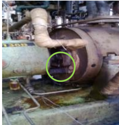
Figura 64: Equipo SP138B con plan API 32/62.
