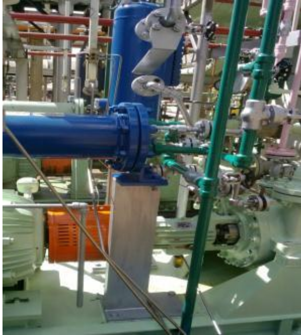
Figura 68. Plan API 21/52 del equipo SP171A.
