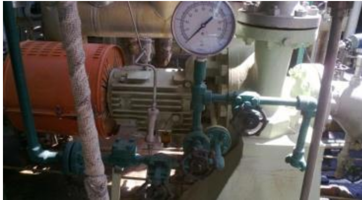
Figura 61. Equipo SP150 con Plan API 62.
