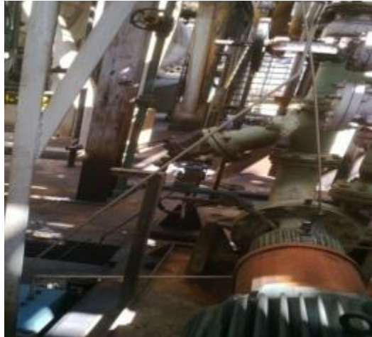
Figura 60. Equipo SP153C con Plan API 62.
