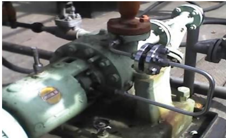
Figura 27. Ejemplo Plan 11.
