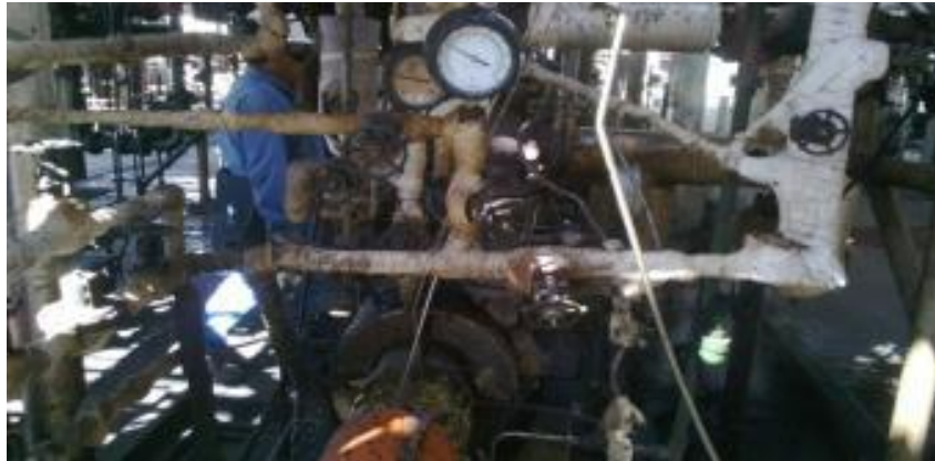
Figura 66. Plan API 32 del equipo SP137C.
