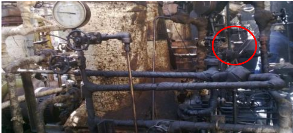
Figura 54. sistema de vapor al sello de la SP313E.
