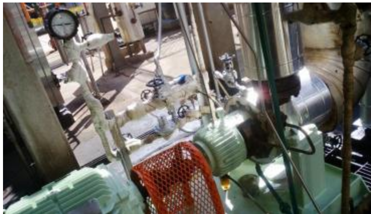
Figura 65: Equipo SP152C con plan API 11/62.
