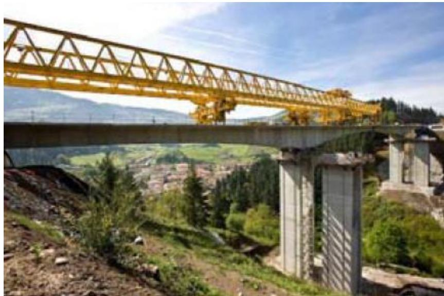
*Figura 33.* Ejecución del tablero del viaducto de Uztarreta
