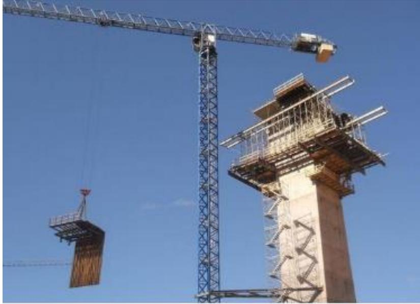
*Figura 20.* Ejecución de la losa superior
