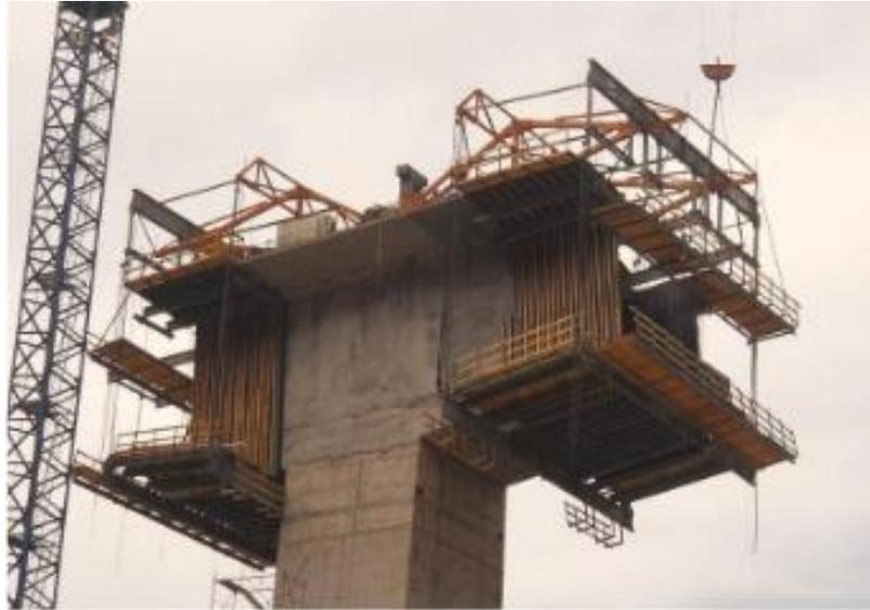
*Figura 19.* Construcción de alzados laterales y las riostras transversales
