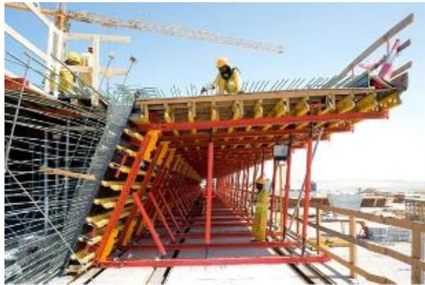
*Figura 24.* Vigas de celosía y arriostramiento horizontal
