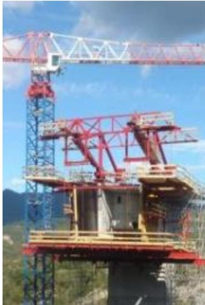
*Figura 26.* Montaje estructura de soporte de andamios y pisos de trabajo
