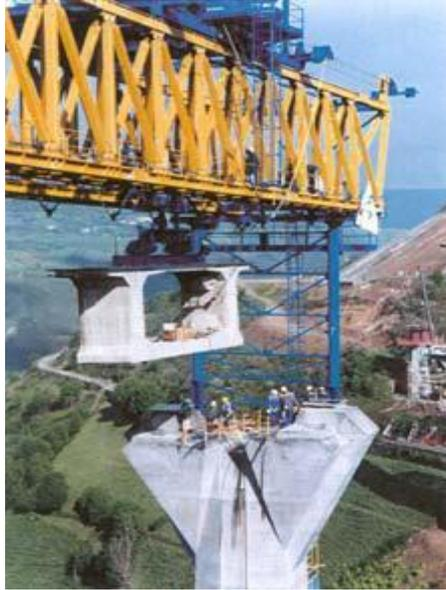
Figura 35. Lanzamiento de la dovela
