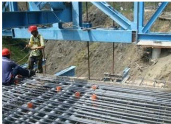
*Figura 25.* Armadura de los encofrados
