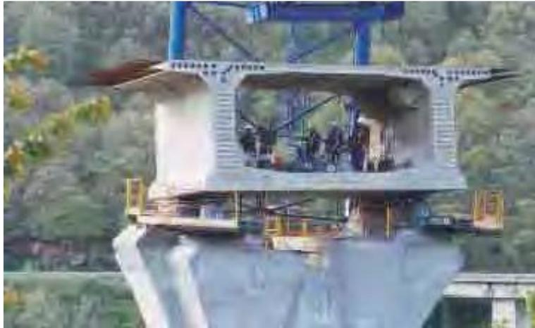
*Figura 34.* Posicionamiento de la Dovela en la cabeza de la pila
