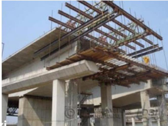
*Figura 22.* Montaje de carro de avance
