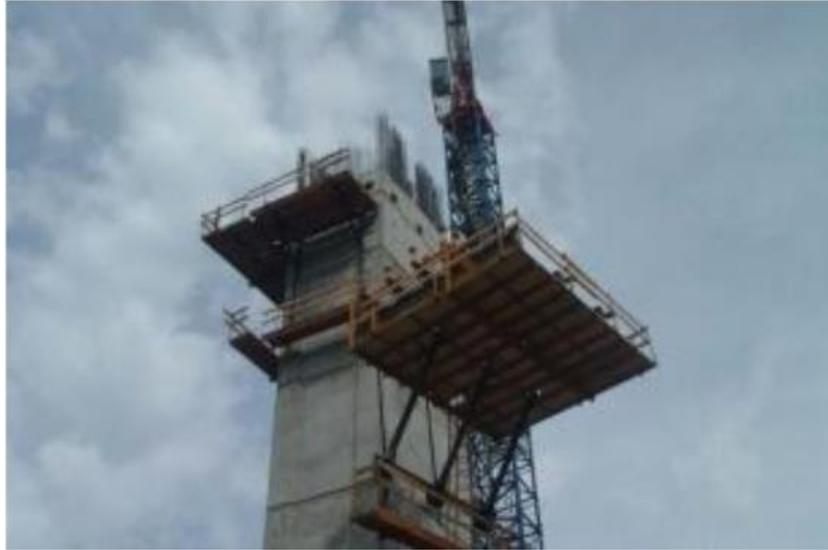
*Figura 18.* Construcción de la solera o losa inferior
