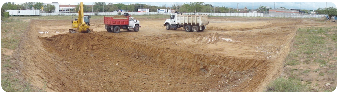
Figura 48 Corte y Cargue de Volquetas
