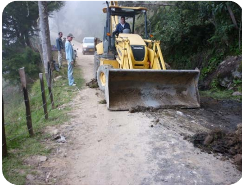
Fuente: Registro fotográfico Construarea S.A.S.
