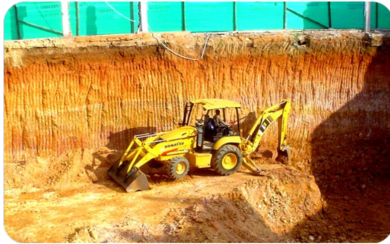
Fuente: Registro fotográfico Construarea S.A.S.
