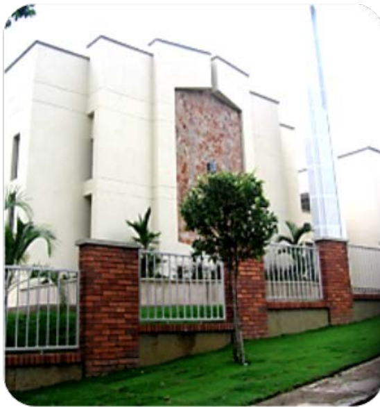
Figura 8 Administración delegada Ampliación y Remodelación Capilla Diamante. Bucaramanga, Santander.
