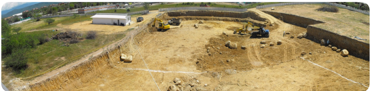
Figura 32 Preparación del terreno San Juan Plaza
