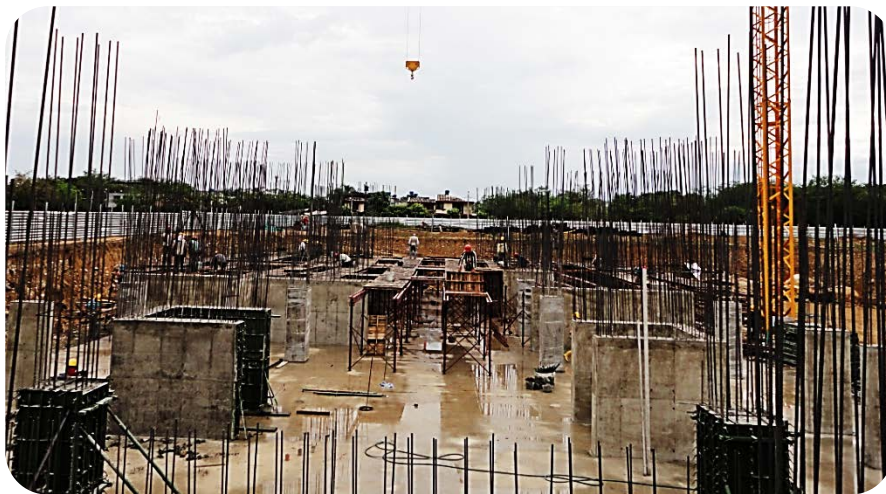
Figura 40 Elevación estructural de sótano 1 a sótano 2
