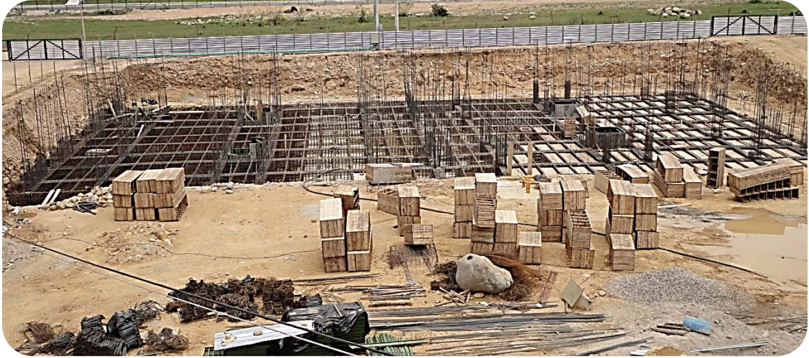
Fuente: Registro fotográfico Construarea S.A.S.
