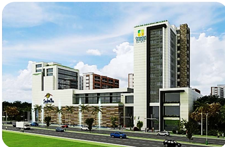
Figura 12 Proyecto en ejecución San Juan Plaza. Neiva, Huila.
