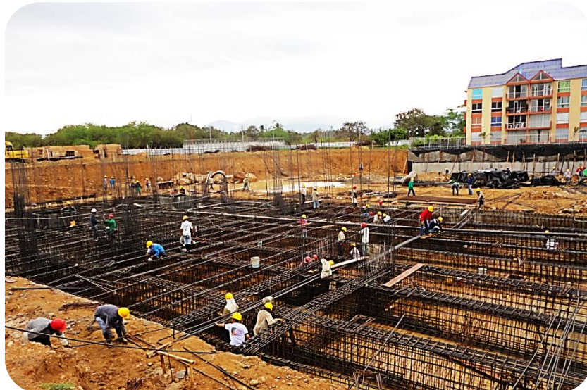
Figura 34 Cimientos Torre I.
