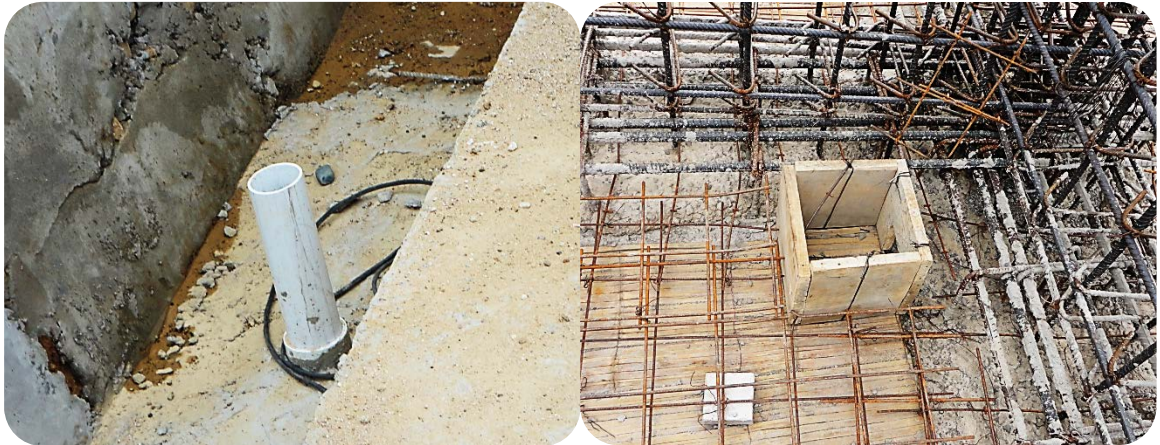
Figura 39 Colocación de instalaciones, Torre I.
