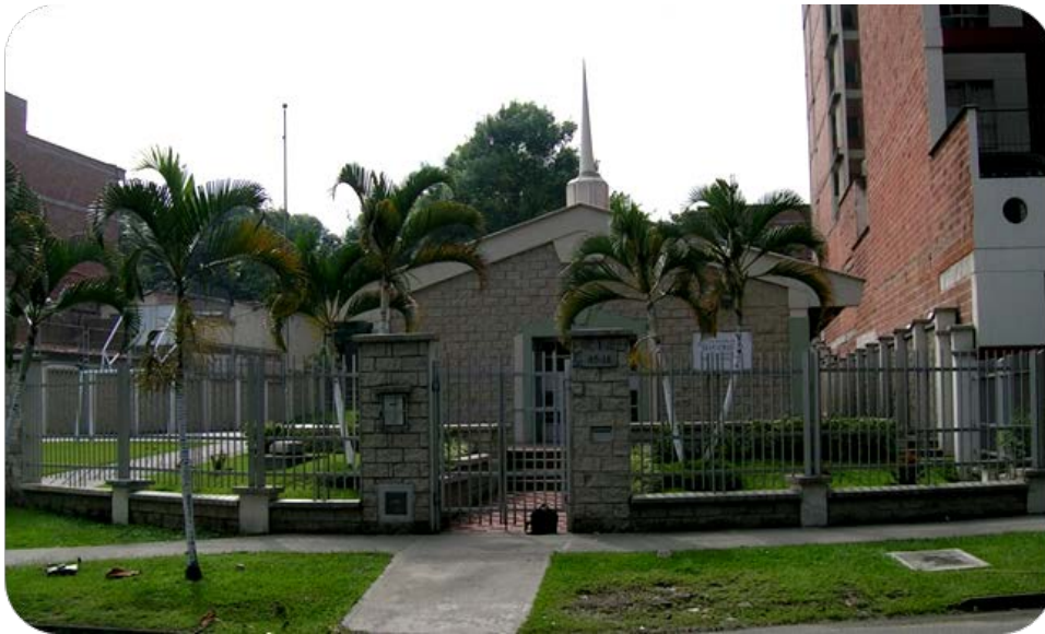
Fuente: Registro fotográfico Construarea S.A.S.
