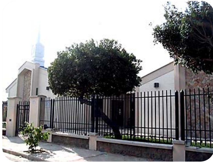
Fuente: Registro fotográfico Construarea S.A.S.
