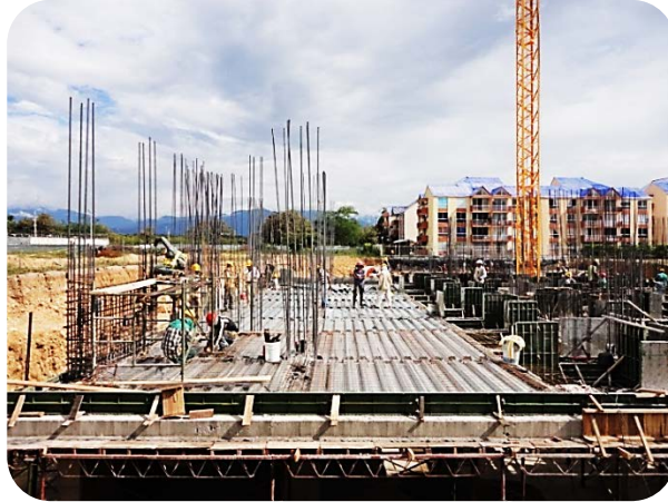
Figura 43 Preparación para fundida de placa sótano 2.
