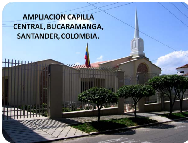
Figura 11 Remodelación y Reforzamiento Estructural Capilla Central, Estaca. Bucaramanga, Santander.
