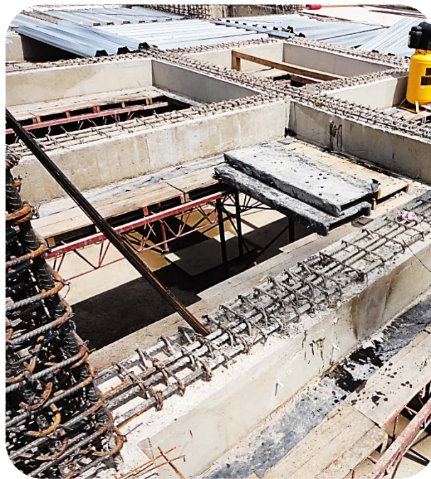
Figura 42 Vigas fundidas sótano 2, San Juan Plaza.
