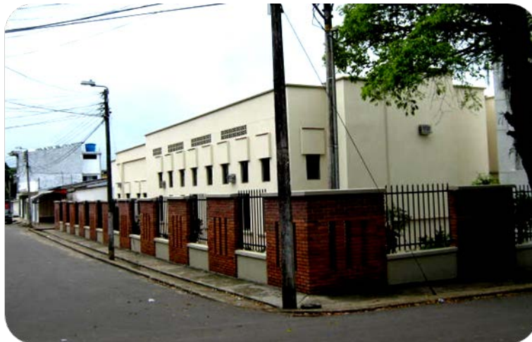
Fuente: Registro fotográfico Construarea S.A.S.
