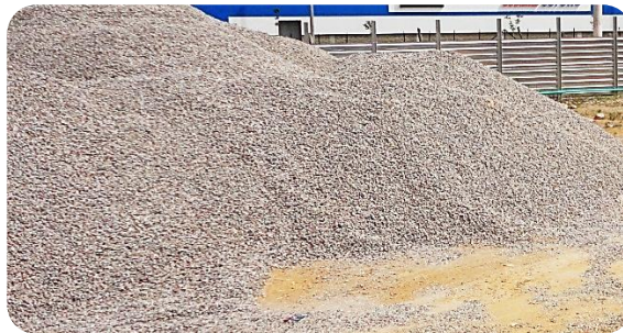
Figura 17 Grava, obra San Juan Plaza.
