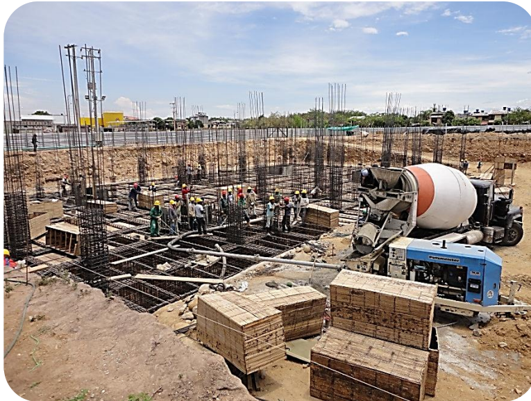
Figura 35 Fundida de cimientos Torre I.
