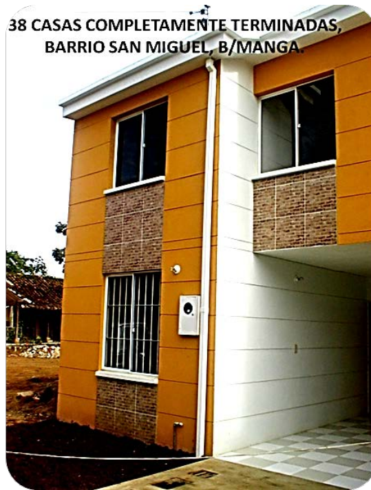
Fuente: Registro fotográfico Construarea S.A.S.
