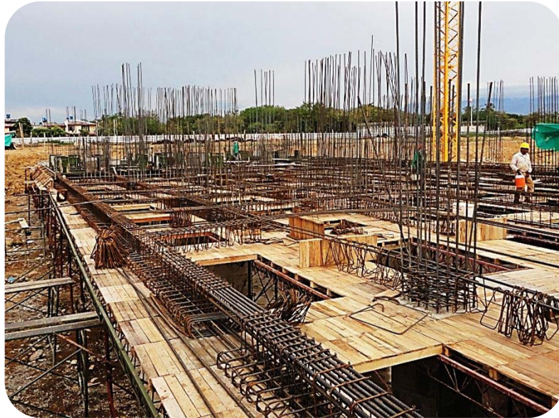
Figura 41 Armado Sótano 2, San Juan Plaza.
