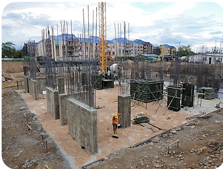
Figura 38 Cimentación pantallas y columnas en Torre I.
