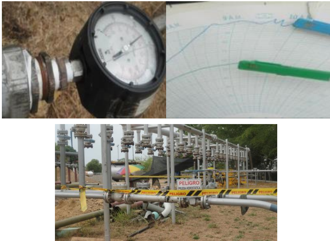
Imagen 4. Prueba hidrostática
