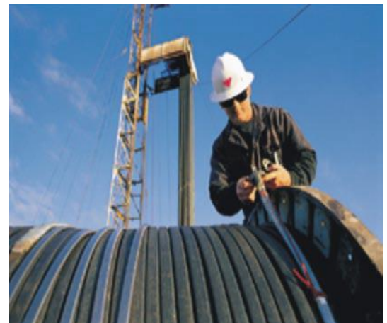
Figura 7. Cable de Potencia
