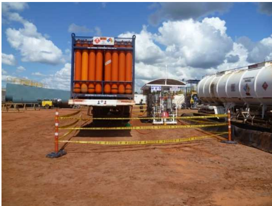
Ilustración 10. Conexión de la línea de gas de 2" entre la Descompresora y el generador 1
