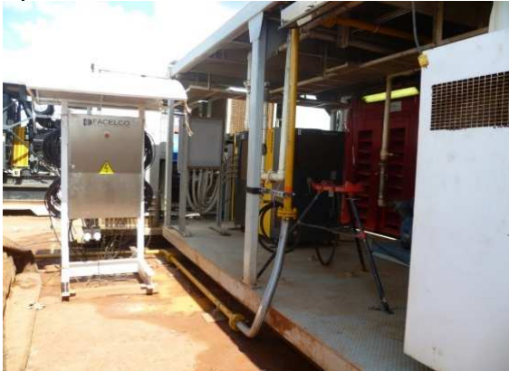
Ilustración 12. Línea de gas de 2" entre la Descompresora y el Generador
