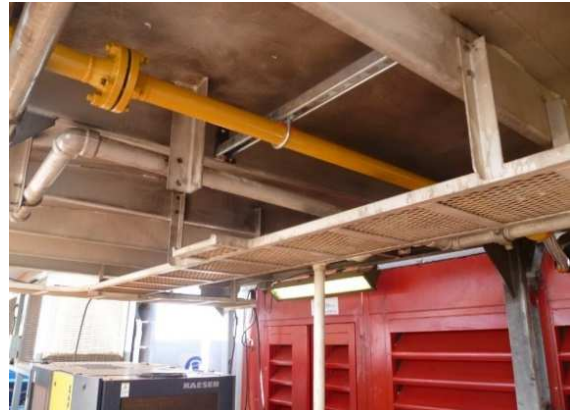
Ilustración 12. Línea de gas de 2" entre la Descompresora y el Generador
