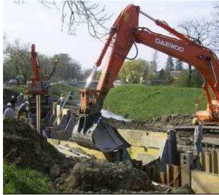
Figura 31. Reorganización del alcantarillado paralelo al río Leising, Viena.
