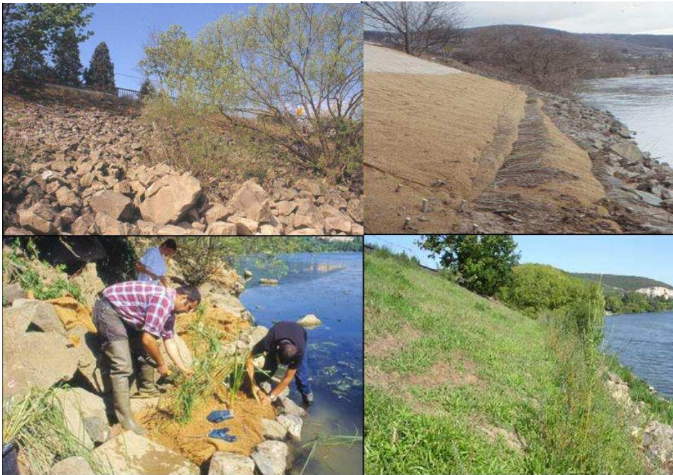
Figura 20. Revegetalización del enrocado rip-rap en el río La Saone.
