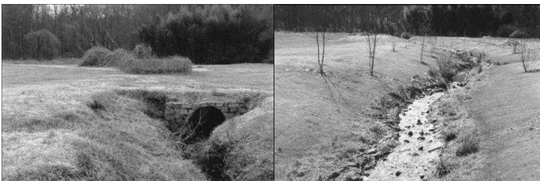
Figura 25. a) Una quebrada entubada en el parque Longdale Park cerca a Atlanta. b) La misma quebrada un año después de destaparla. La sección del frente estaba previamente abierta, sin embargo sus orillas fueron reajustadas.
