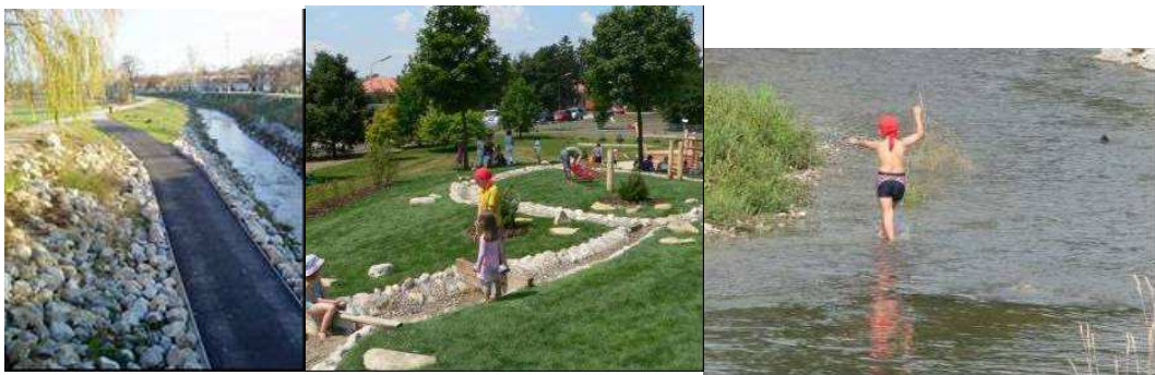
Figura 43. Creación de senderos peatonales (con superficies permeables) y un parque acuático en el río Leising, Viena.
