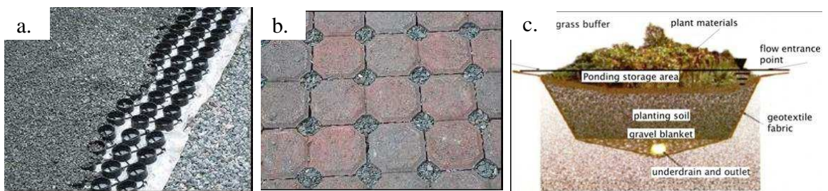
Figura 18. Detalle de: a) Matriz de pavimento de grava; b) Pavimento permeable; y c) Celda de bioretención; en el parqueadero de la playa del lago Silver, Wilmington, Massachusetts.
