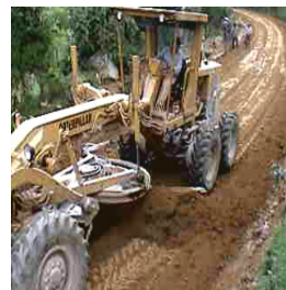
Fotografía 9. Material extendido con motoniveladora
