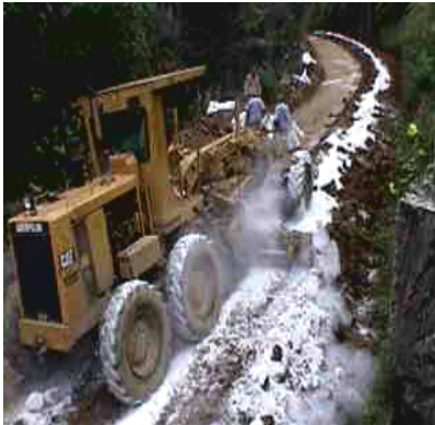
Fotografía 3. Motoniveladora mezclando la cal con el suelo
