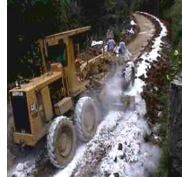
Fotografía 8. Mezcla del suelo con cal
