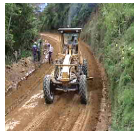
Fotografía 11. Mezcla del silicato
