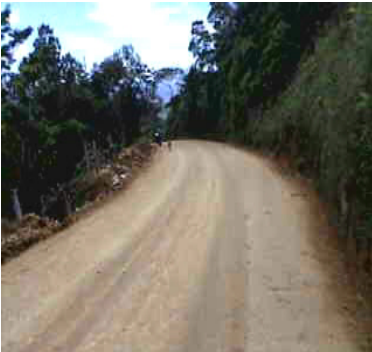
Fotografía 4. Base estabilizada
