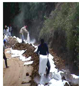
Fotografía 7. Ubicación de los sacos de cal
