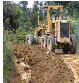
Fotografía 6. Material extendido con la motoniveladora
