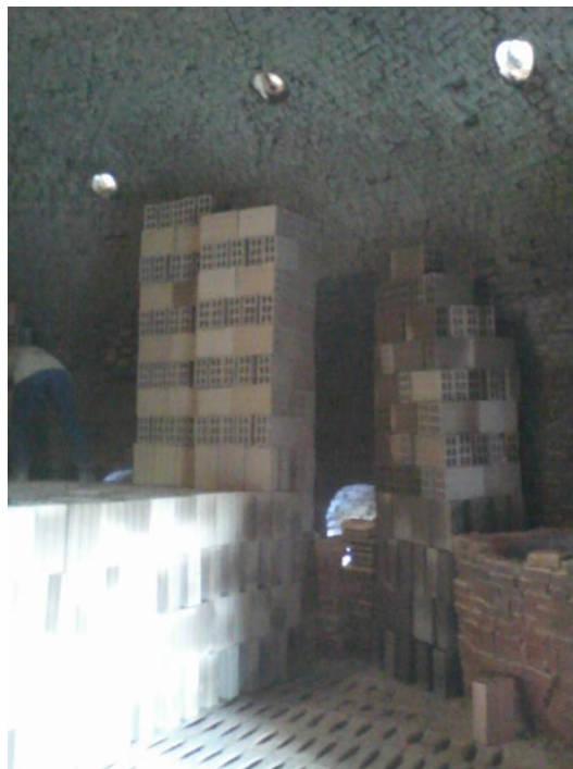
Figura 19. Fotografía de la carga en el horno.
