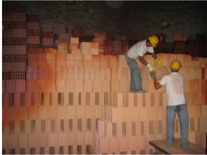
Figura 3. Calidad del ladrillo dentro del horno finalizado el proceso de cocción.
