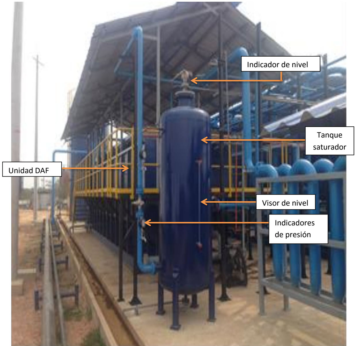
Figura 40. Separador de flotación por aire disuelto (DAF) y tanque saturador
