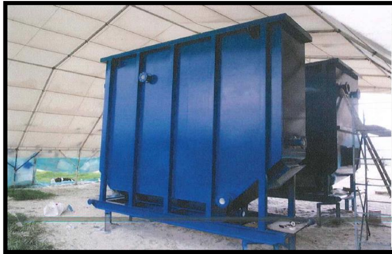
Figura 19. Aspecto exterior de un separador de placas corrugadas.
