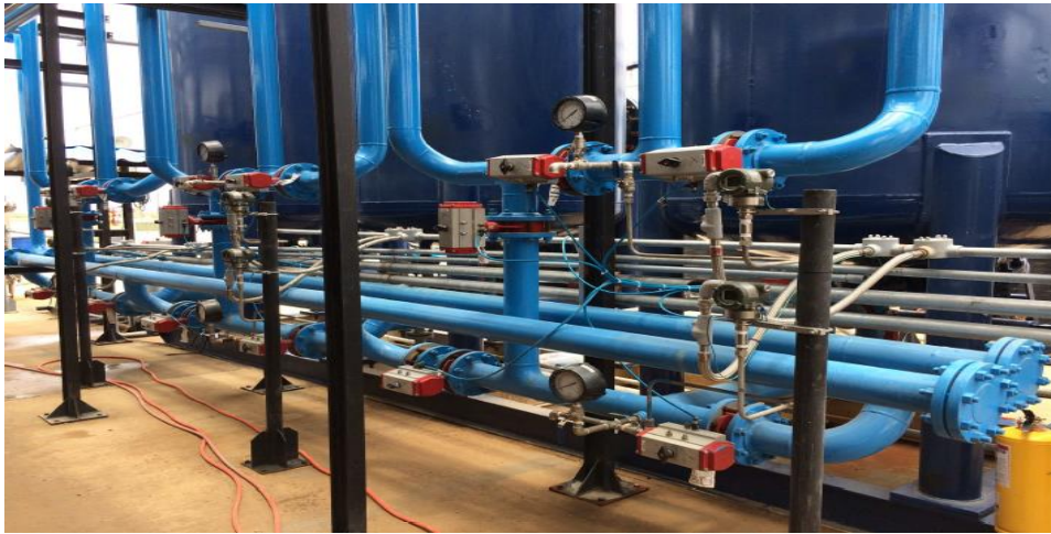
Fuente. TECCA SAS. Manual de operación de los sistemas de Tratamiento de agua de producción para Inyección de la estación de otro campo de la empresa operadora realizado por la empresa Figura 42. Filtros de cáscara de nuez
