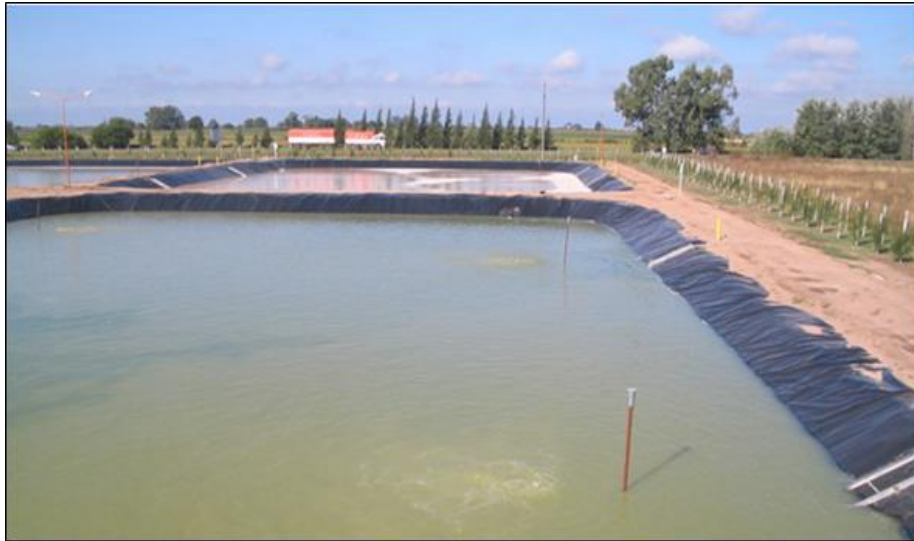
Figura 27. Piscinas para el tratamiento de aguas residuales.
