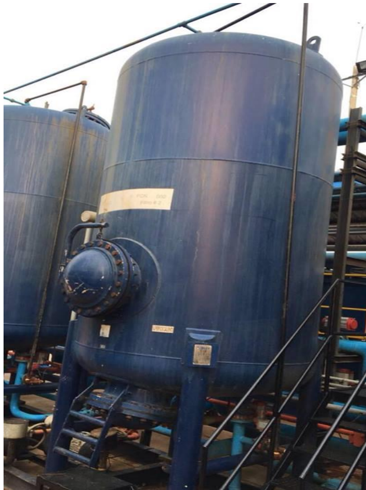
Fuente. TECCA SAS. Manual de operación de los sistemas de Tratamiento de agua de producción para Inyección de la estación de otro campo de la empresa operadora realizado por la empresa Figura 42. Filtros de cáscara de nuez
