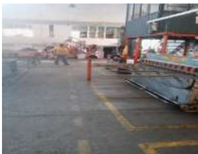
Figura 8. Señalización seguridad industrial.
