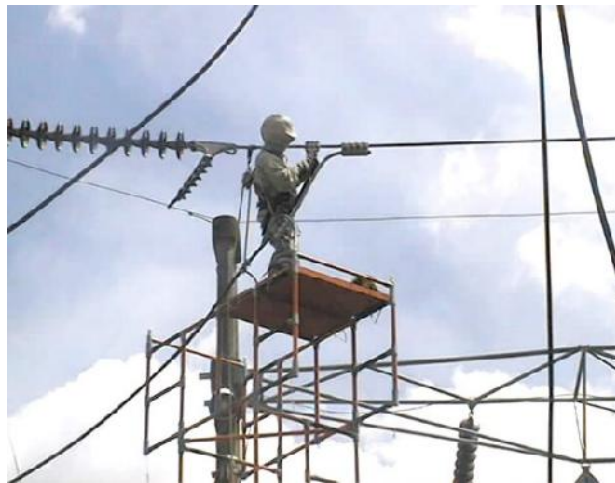
Ilustración 4. Trabajo en línea de transmisión con vestuario conductivo
