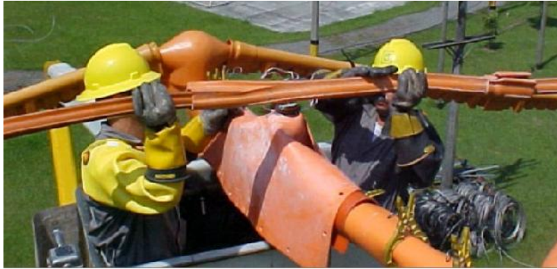
Ilustración 3. Trabajo a contacto con protección, dispositivos y equipos aislantes
