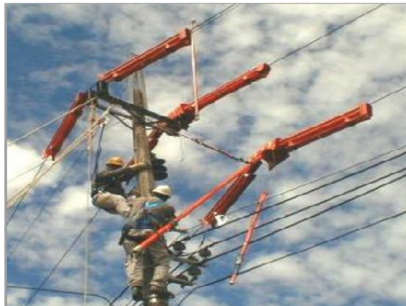
Ilustración 2. Trabajo a distancia segura en líneas energizadas
