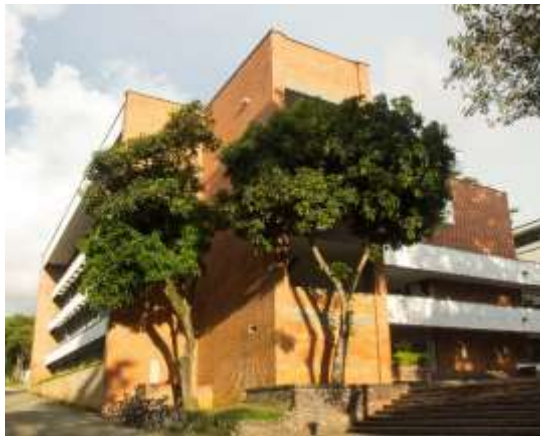
Figura 10. Edificio Camilo Torres
