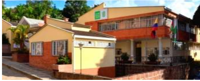
Figura 2. Entrada principal sede Socorro. [4]
