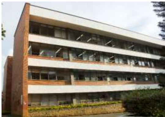
Figura 11. Edificio Camilo Torres
