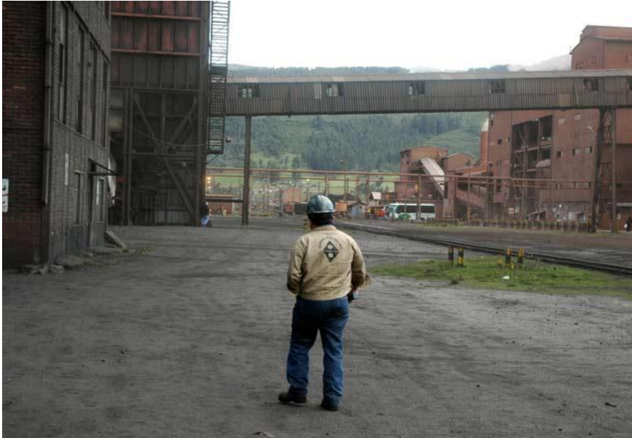
Figura 2. Vista general de planta siderúrgica.
