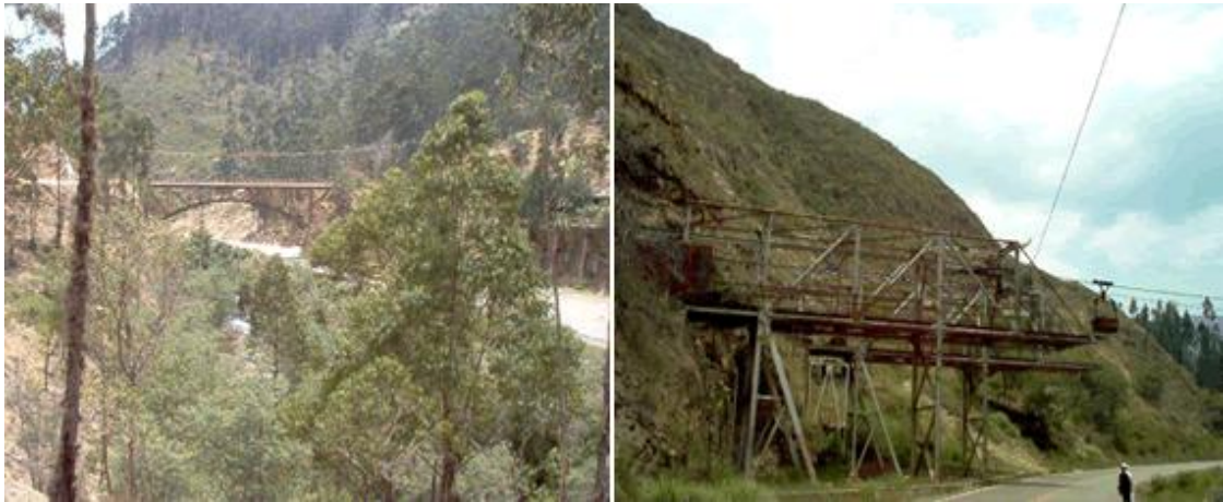
Figura 4. Entrada y Salida de la mina “El Uvo”.
