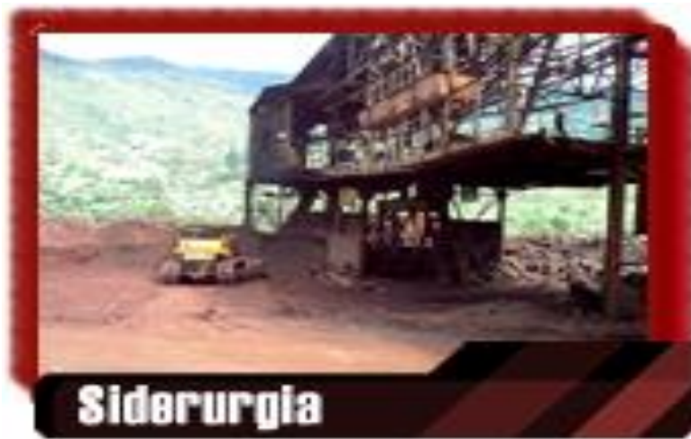
Figura 10. Estación de descargue del cable aéreo
