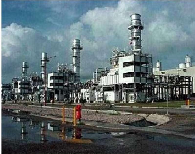
Figura 10. Unidad generadora de energía en Cantarell
