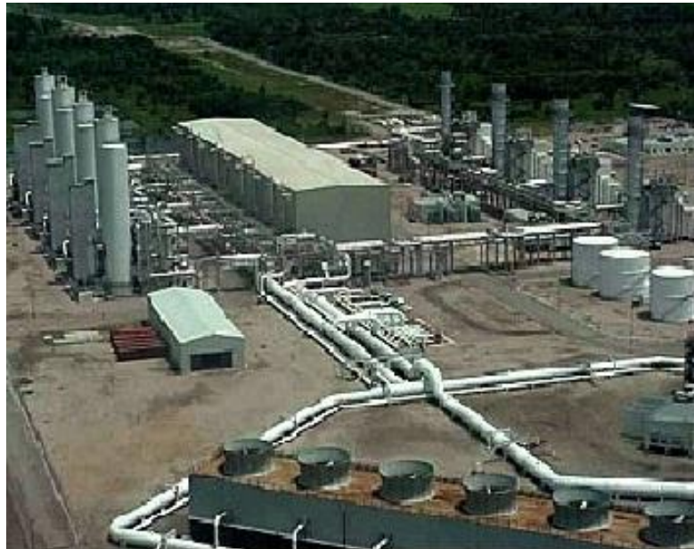
Figura 9. Planta de generación de nitrógeno en Cantarell
