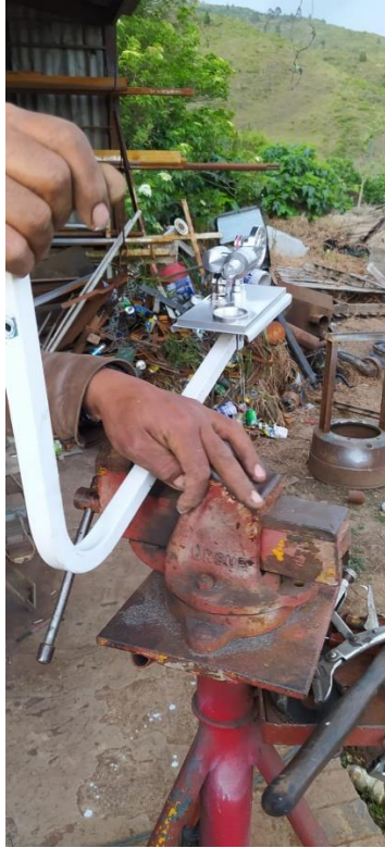
Figura 55: Instalación del motor Stirling al brazo del colector
