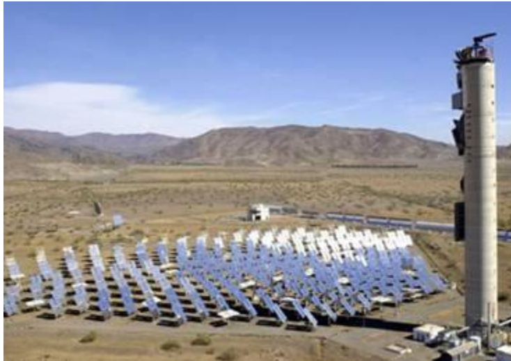
Figura 5: Sistema de Torre Central
