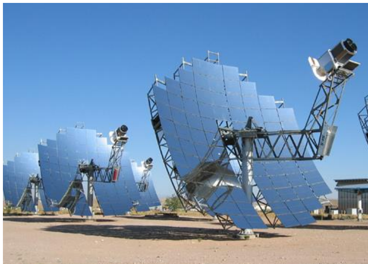
Figura 6: Concentrador Solar Tipo Puntual
