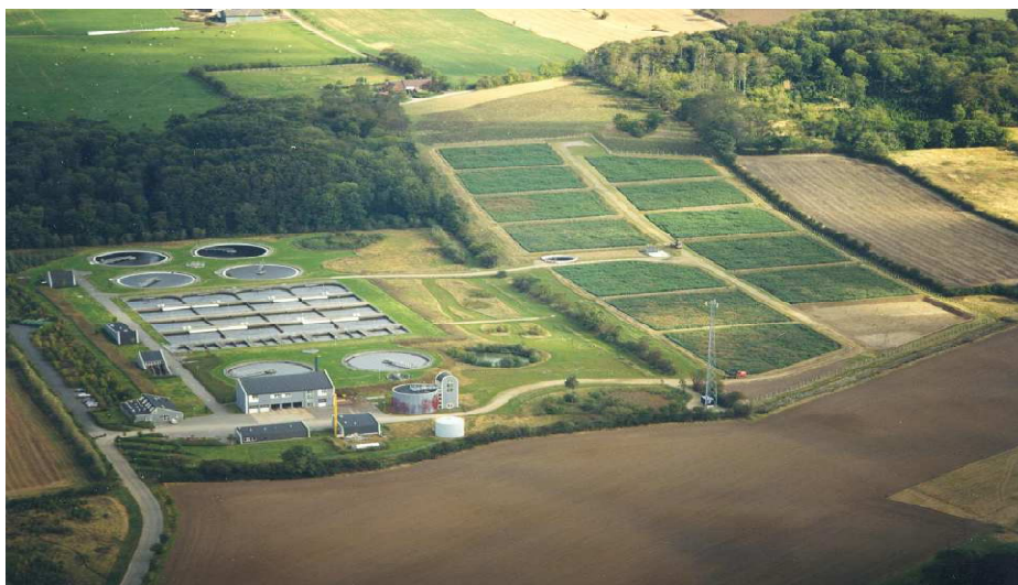
Foto No. 10 Sistema de tratamiento de lodos de una PTAR de Lodos activados en Kolding (Dinamarca)
