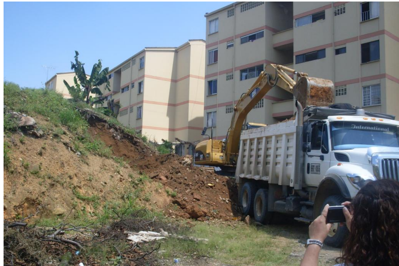
FIGURA 9. Ejecución movimiento de tierras
