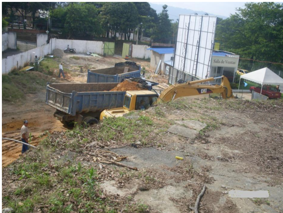
FIGURA 3. Movimiento De Tierra
