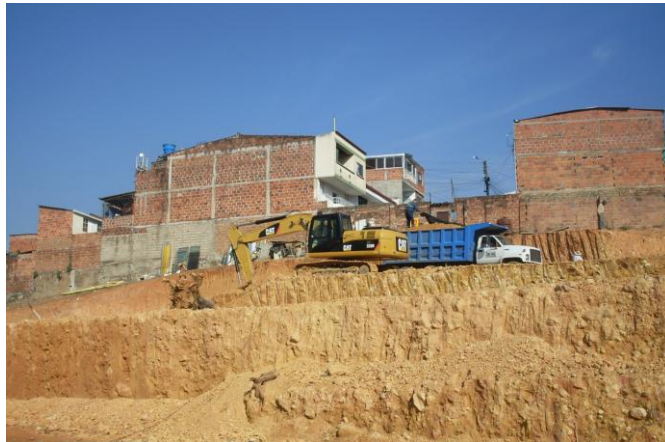
FIGURA 12. EXCAVACIÓN CON MAQUINARIA,
