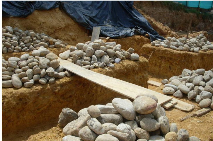
FIGURA 22. Suelo de cimiento
