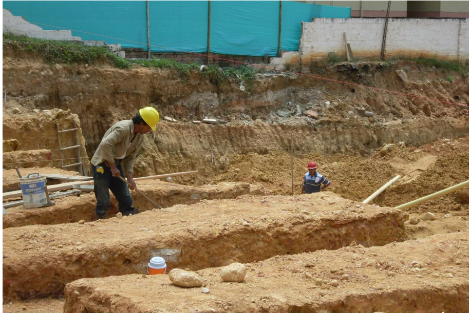
FIGURA 4. Excavaciones para Cimientos
