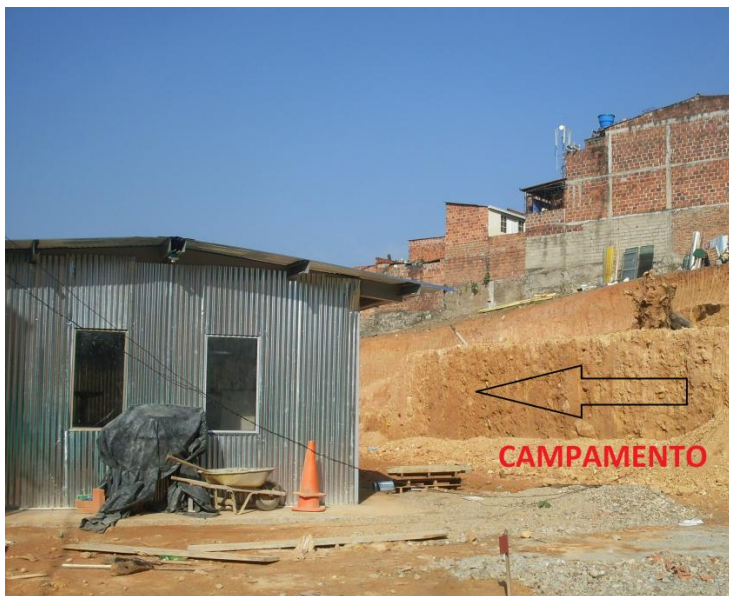
FIGURA 11. Instalación del campamento
