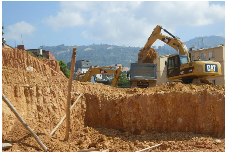
FIGURA 14. Cargue material removido
