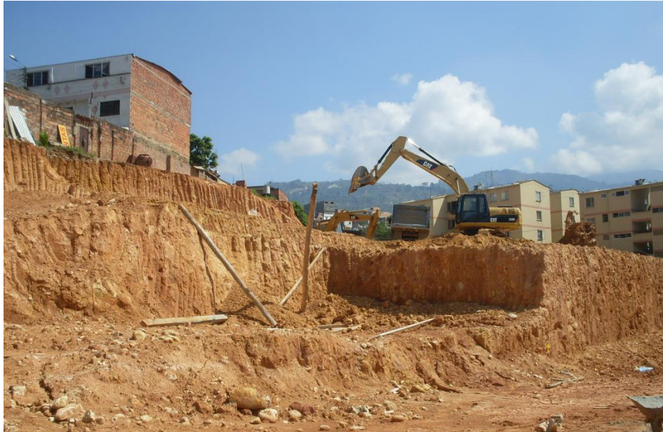
FIGURA 5. Movimiento de tierra
