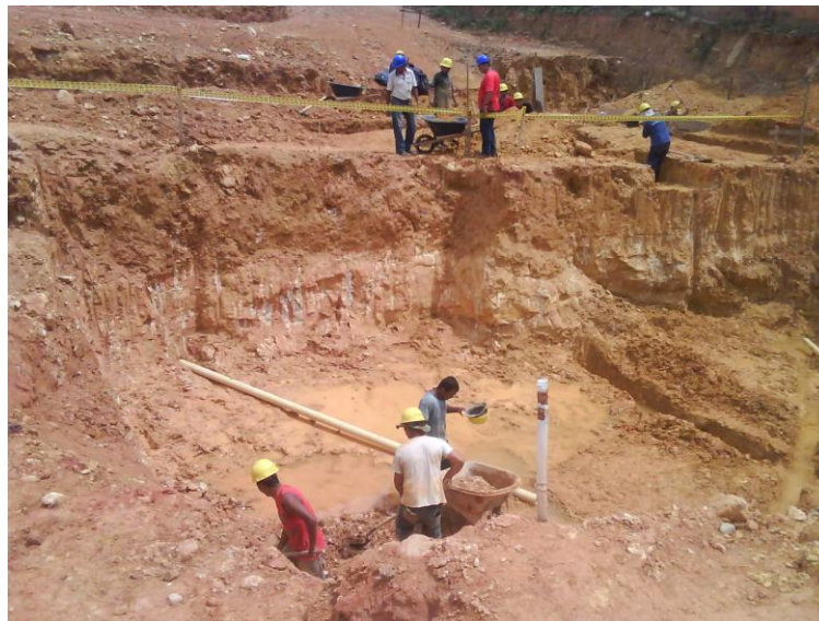
FIGURA 15. Excavaciones para cimentación
