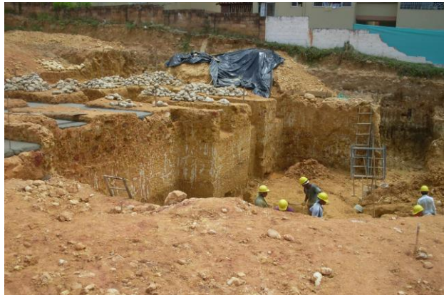
FIGURA 7. Trabajos de cimentación
