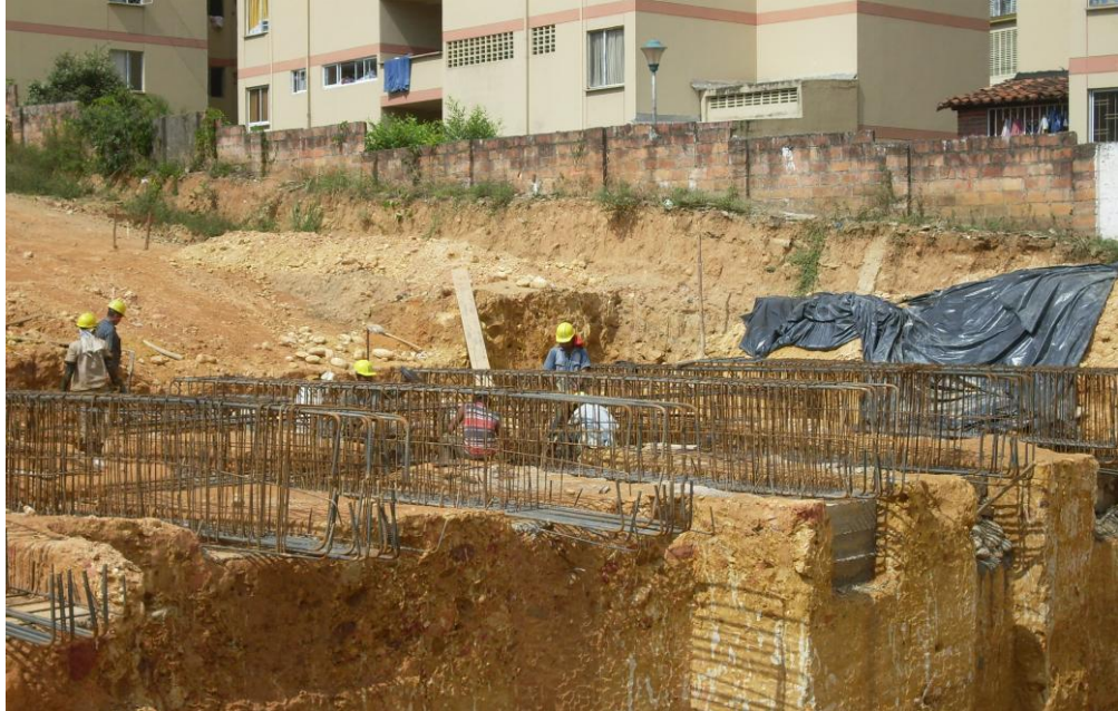
FIGURA 26. Refuerzo de la cimentación
