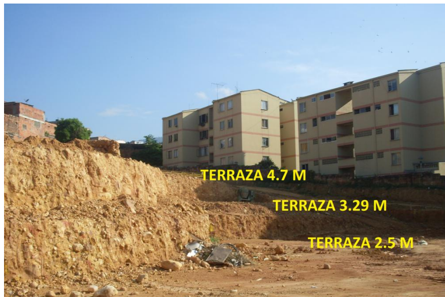
FIGURA 13. NIVELES DE EXCAVACIÓN,
