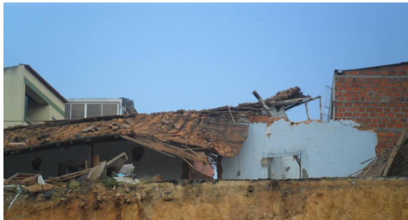
FIGURA 10. Remoción de estructuras existentes
