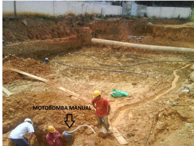
FIGURA 19. Instalación motobomba
