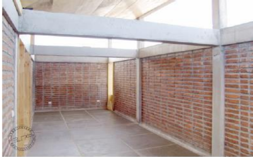
Figura 4. Muros de diafragma dentro de pórticos.
