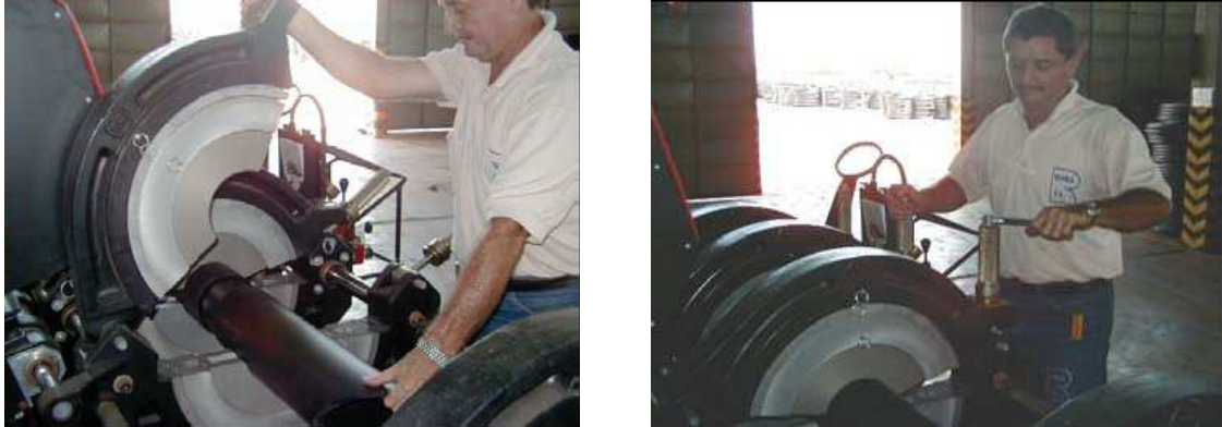
Figura 21. Instalación De Equipo
