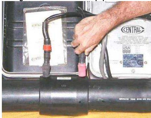
Figura 18. Conexión Del Equipo De Soldar
