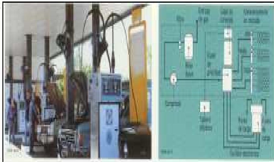
Figura 4. Sistema De Carga Rápida De GNV, Con 3 Banco De Almacenamiento Y Tres Líneas De Flujo
