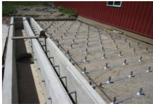
Figura 19. Conducto Instalado. Adaptado de Solarroadways.com. (2017) R&D- SolarRoadways. Disponible en: http://www.solarroadways.com/Research/Research .
