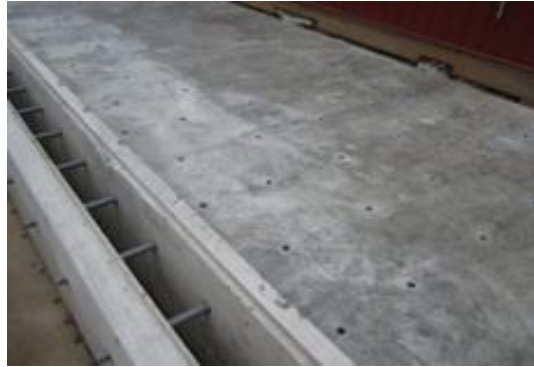
Figura 20. Base vertida-contiene vidrio reciclado. Adaptado de Solarroadways.com. (2017) R&D-SolarRoadways. Disponible en: http://www.solarroadways.com/Research/Research .
