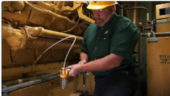
Figura 49. Toma de muestra de aceite
