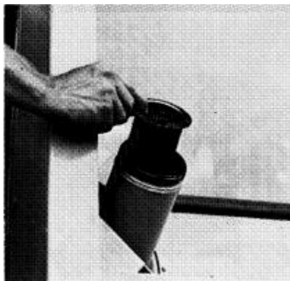
Figura 63. Antefiltro de combustible
