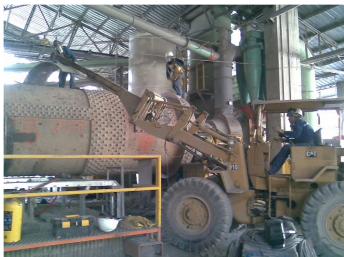
Figura 39. Cargador posicionando la ruana en el molino
