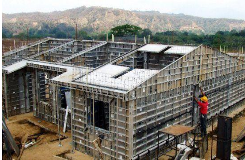
Figura 5. Sistema industrializado con formaleta
