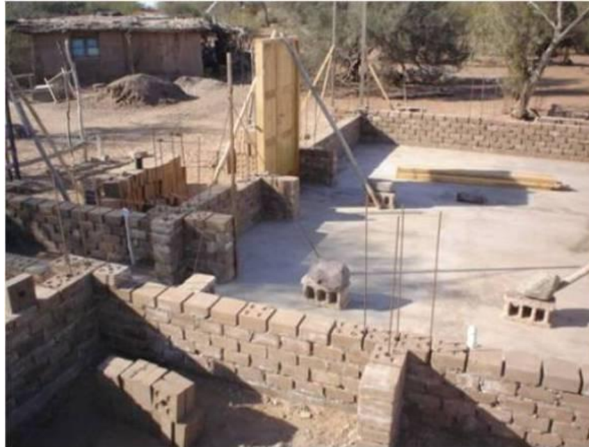
Figura 3. Sistema constructivo tradicional.
