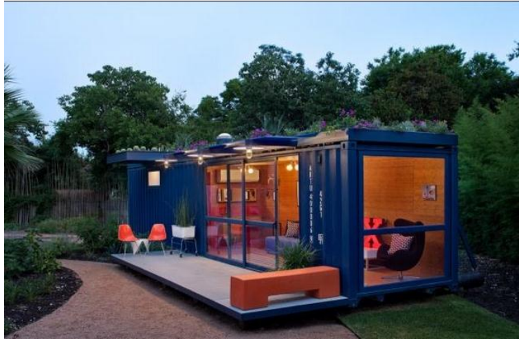
Figura 6. Prototipo de vivienda realizado a partir de contenedores metálicos.
