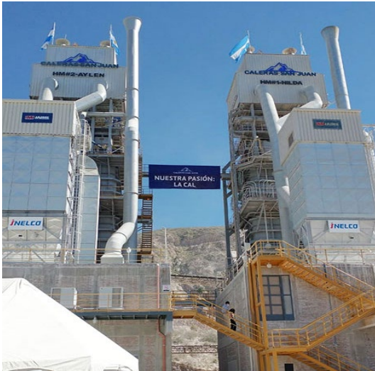
Figura 4. Horno Regenerativo Marca Maerz en Caleras San Juan, Argentina
