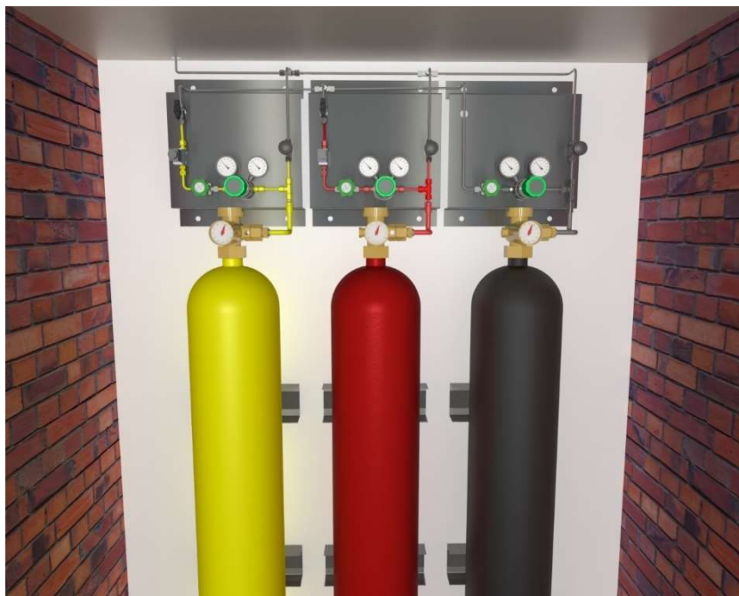
Figura 15. Ubicación de los cilindros con los gases puros requeridos para la dilución
