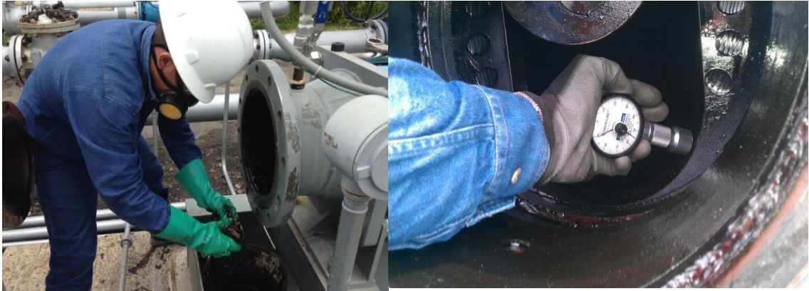
Figura 35. Imágenes de las pruebas finales en la bomba multifásica. La primera imagen es la limpieza del área de prueba, y la segunda imagen hace referencia a la prueba de dureza en el elastómero.
