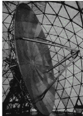
Vista interior del radar de banda S del NSSL donde es posible observar el ródomo y el reflector (o disco) de unos 9 m de diámetro
