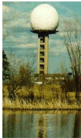
Radars de banda S del Marshall radar Observatory (MRO), en Montreal, Canadá, con un disco de unos 10 m de diámetro
