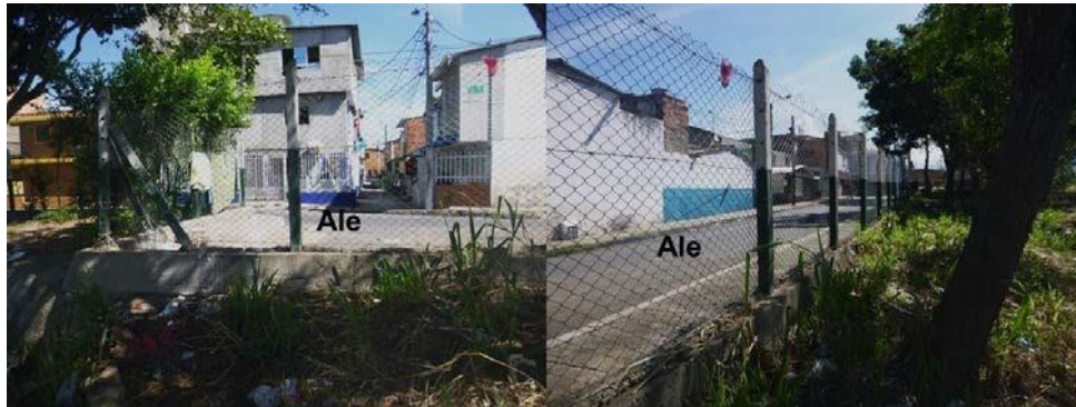
Figura 36. Zona de modificación de morfología del terreno por excavación y/o relleno, por acción de expansión de la ladera para construcción.
