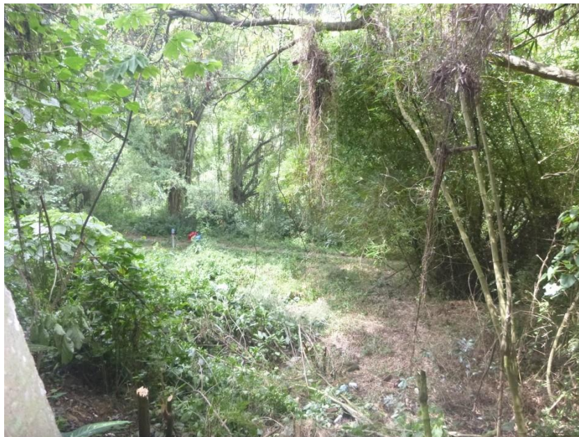
Figura 13. Pie del talud.
