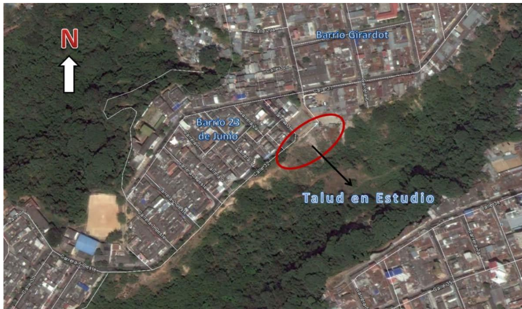
Figura 1. Talud Costado Sur de la Calle 32 entre Carreras 1A-6 – Barrio 23 de Junio
