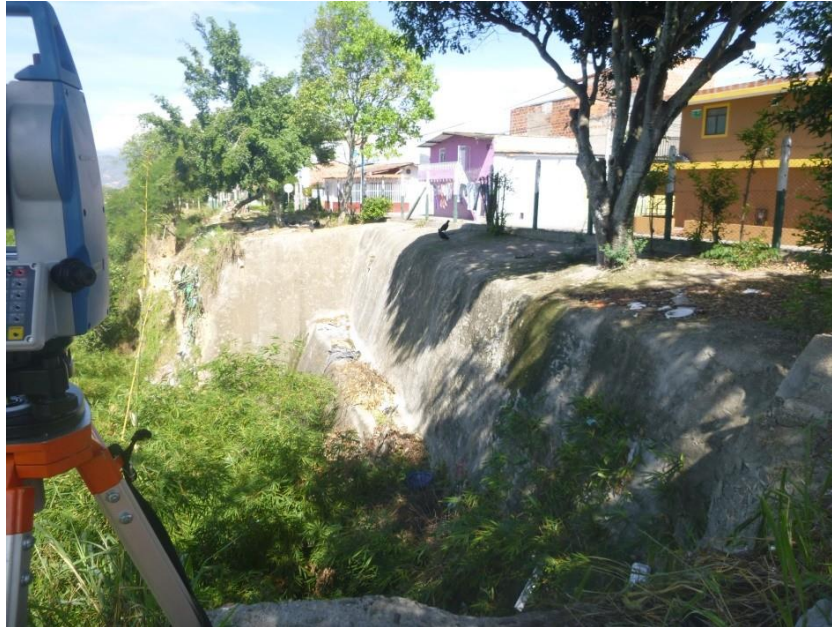
Figura 6. Concreto lanzado actual.
