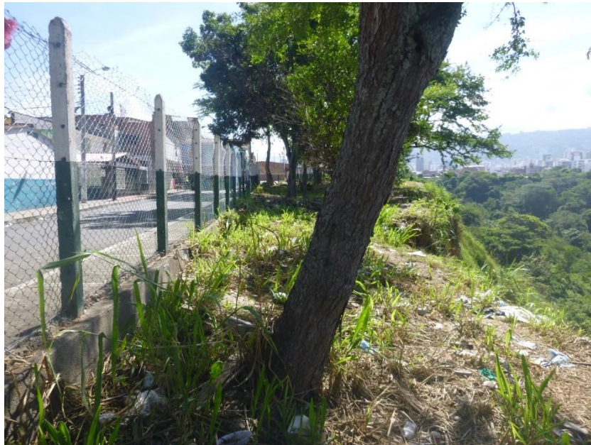
Figura 7. Corona del talud cerca al borde de la calle 32.
