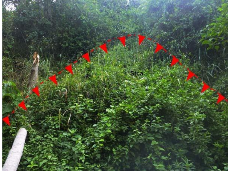
Figura 26. Visto al NW, indicios de movimiento se observa corona de deslizamiento.
