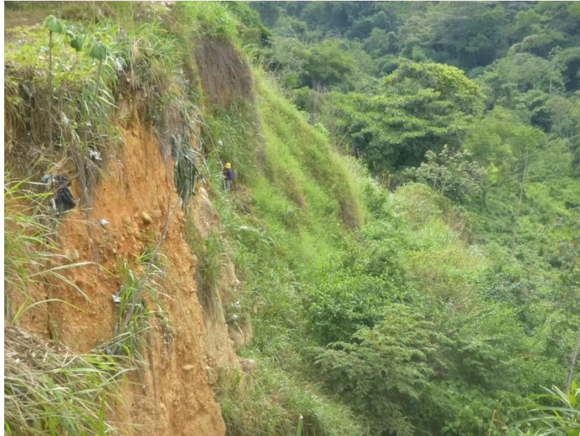
Figura 10. Topografía del talud con la ayuda de una línea de vida.
