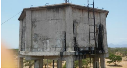
Figura 6. Agua cruda cayendo al tanque
