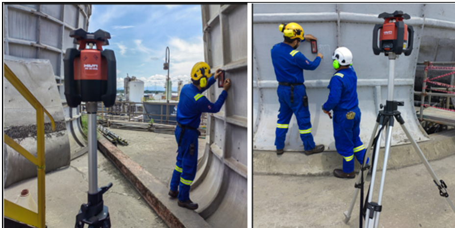
Figura 8. Medición de la Altura Requerida en los Conos
