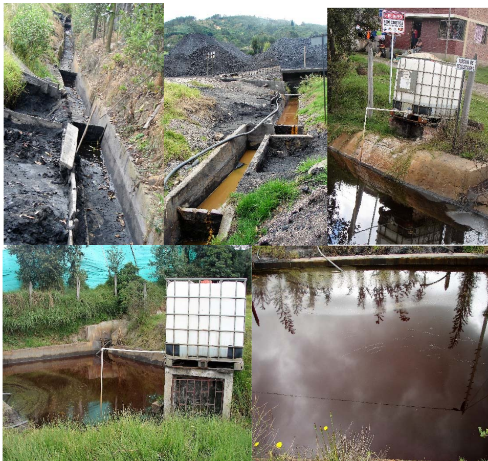
Figura 5. Sistema de recolección y tratamiento de AMD en el centro de acopio de carbón El Triunfo.
