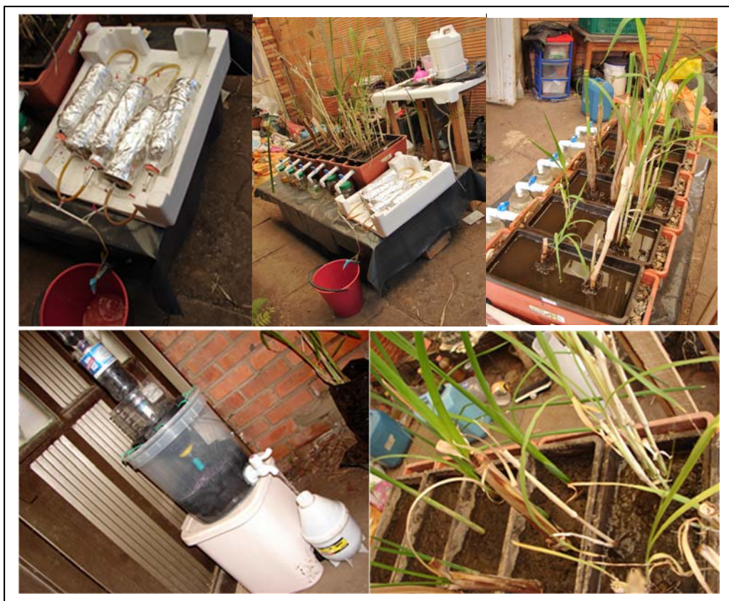
Figura 38. El sistema de tratamiento completo de AMD en operación.
