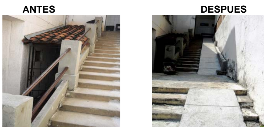
Foto 21. Escaleras de acceso a los cuartos de almacenamiento (antes y después)
