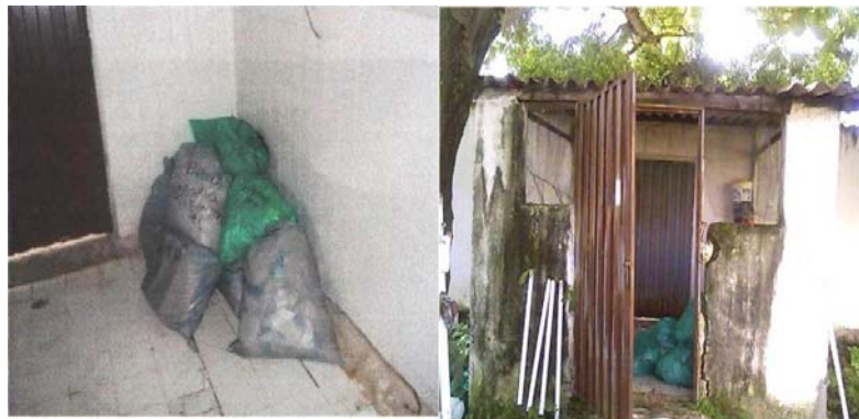
Foto 8. Cuarto de almacenamiento central inicialmente.
