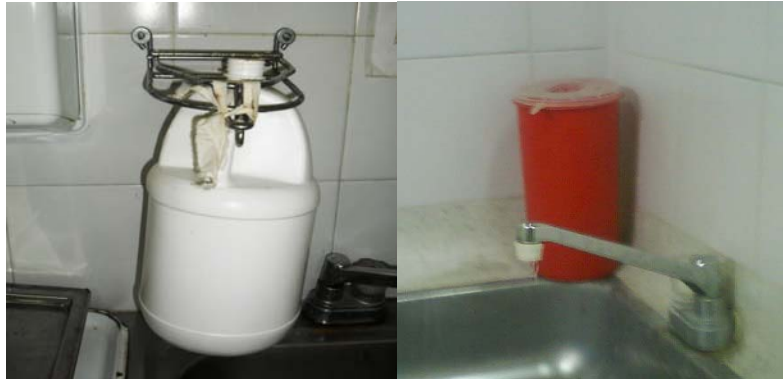
Foto3. Contenedores utilizados inicialmente en la E.S.E
