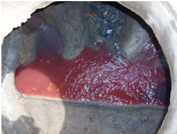
Foto 23. Prueba a canaleta con Conexión Errada.
