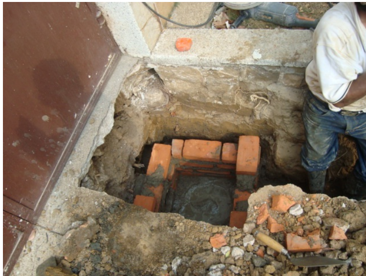
Foto 17. Arreglo de acometidas debido a conexiones erradas.
