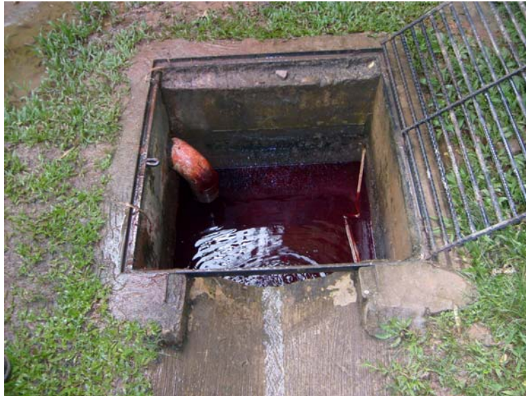
Foto 22. Prueba a canaleta en instalaciones Santa Teresita.
