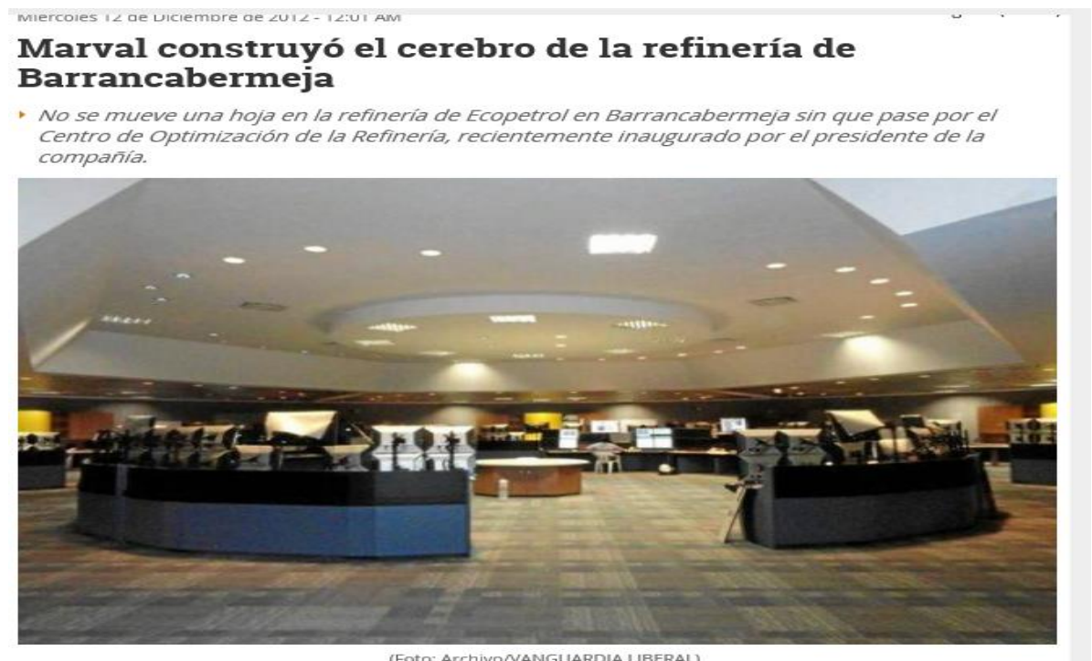
Figura 24. Sala de Control Central dentro de la Refinería de Barrancabermeja ECOPETROL
