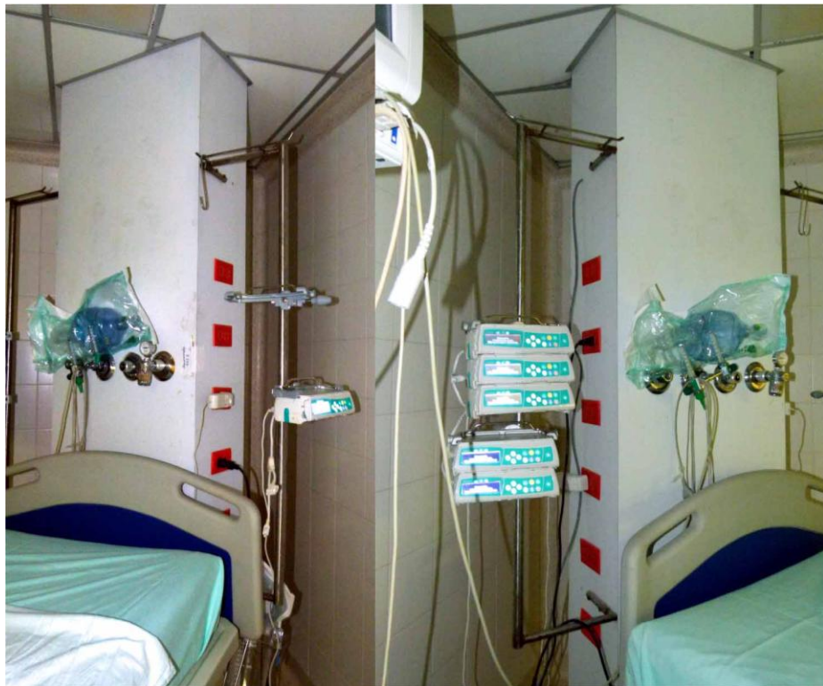
Figura 7. Columna piso-techo de madera implementada actualmente
