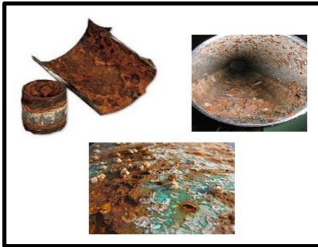
Figura 61. Corrosión de tuberías 98
