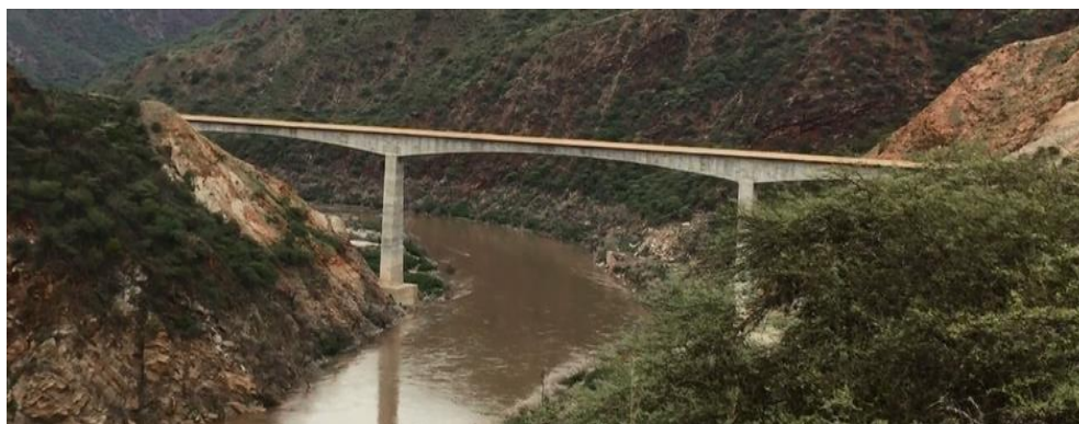
Figura 23. Puente Gómez Ortiz después del comienzo de llenado del embalse Hidrosogamoso Fuente: Autor. (Tomada el 18 de febrero de 2016)
