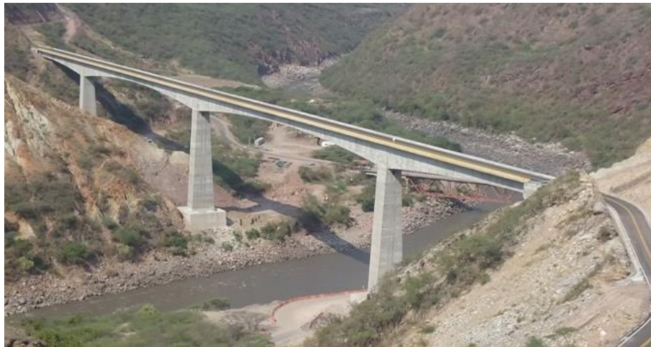
Figura 5. Nuevo Puente Gómez Ortiz Fuente: (ISAGEN S.A. E.S.P, 2015)
