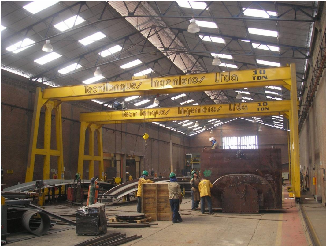
Figura 7: Planta de Producción. Nave 2.
