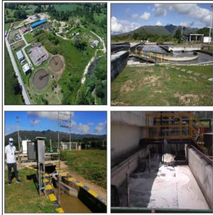
Figura 8. Evidencia fotográfica PTAR El Santuario
