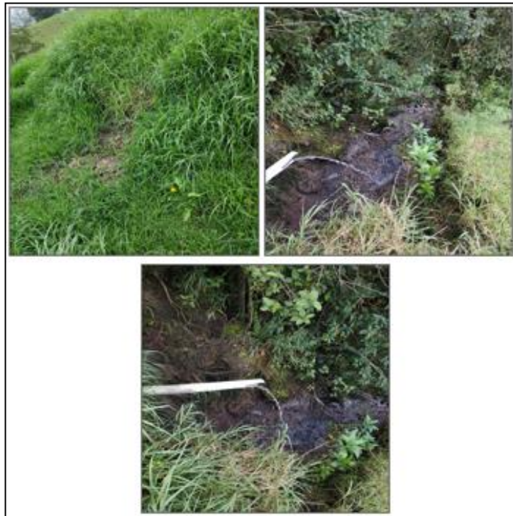
Figura 13. Panorámica estado actual vertimiento Gramal
