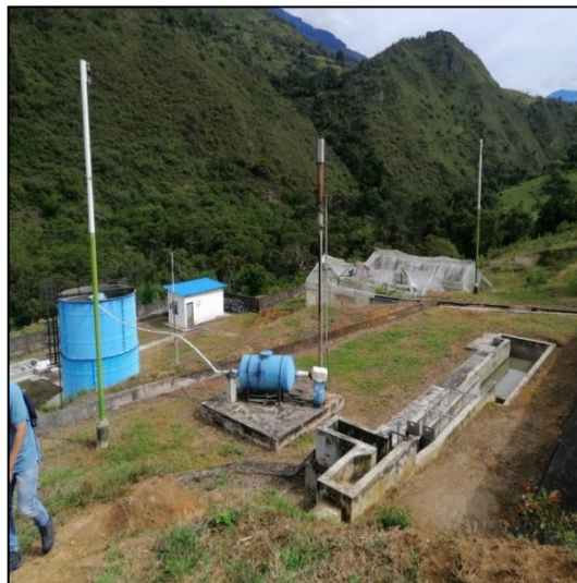
Figura 6. Visita Planta de Tratamiento de Aguas Residuales (PTAR). Matanza, Santander.
