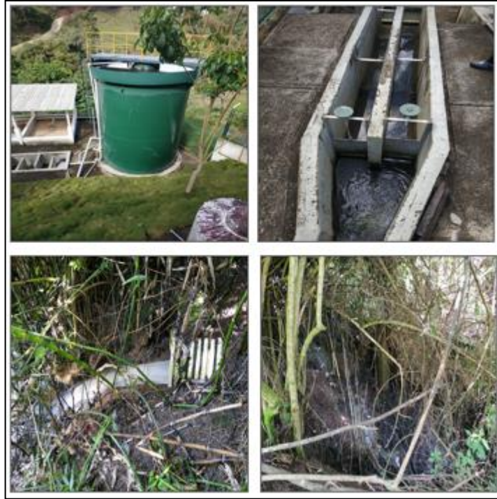
Figura 11. Evidencia Fotográfica visita PTAR CALIFORNIA
