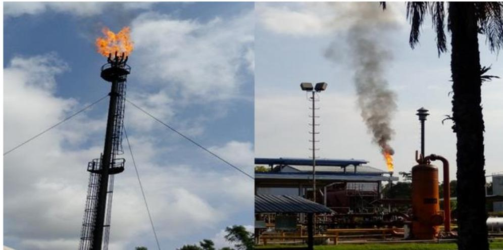
Figura 13. Quema de gas en tea de la Estación 1: a la izquierda se encuentra la imagen de operación normal y a la derecha, la tea en proceso de quema de condensados del KO drum.
