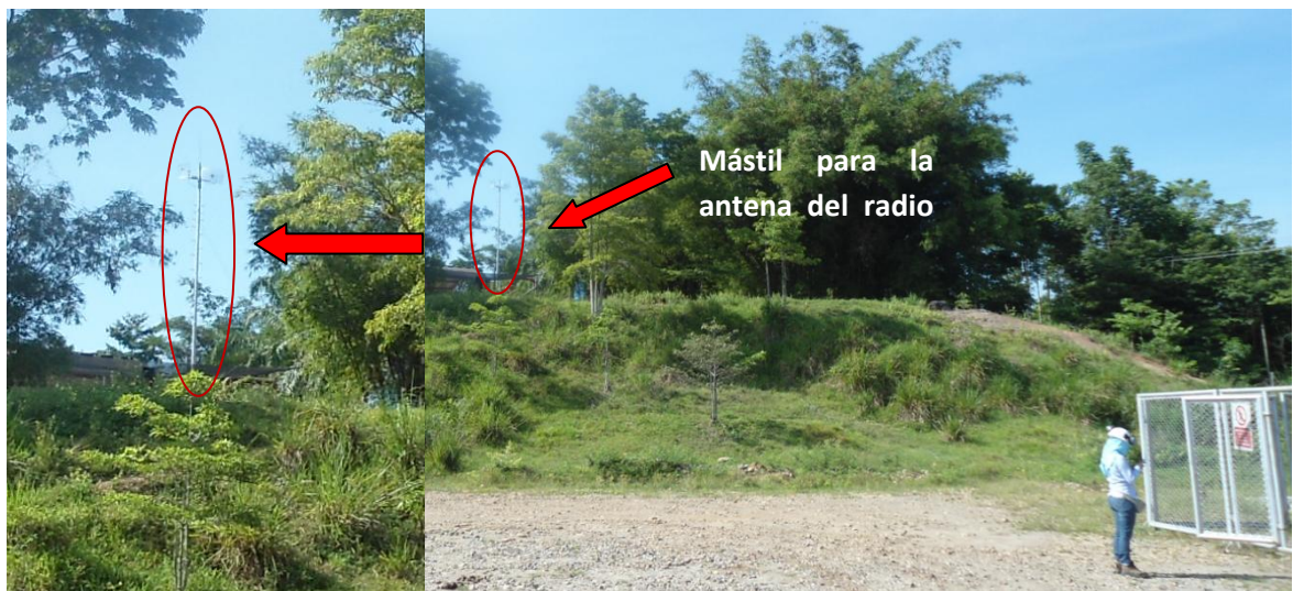
Figura 39. Mástil de antenas de internet inalámbrico. Fuente: Autores.
