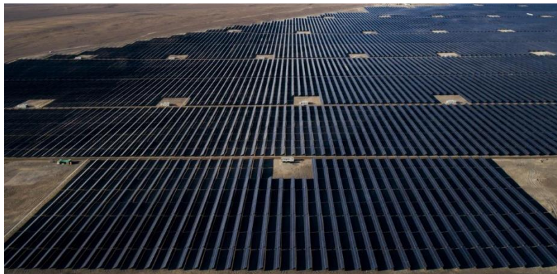
Figura 15. Central de generación de energía solar Rubí a cargo de Enel Green Power.
