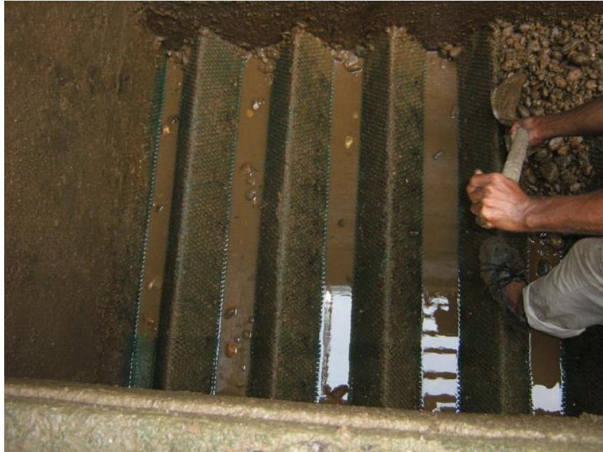
Figura 9. Sistema de filtración con la tecnología de falsos fondos (viguetas)
