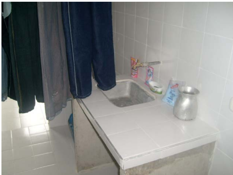
Foto 16. Realización de enchape 0.20x0.20 en muros, mesón y piso de cocina
