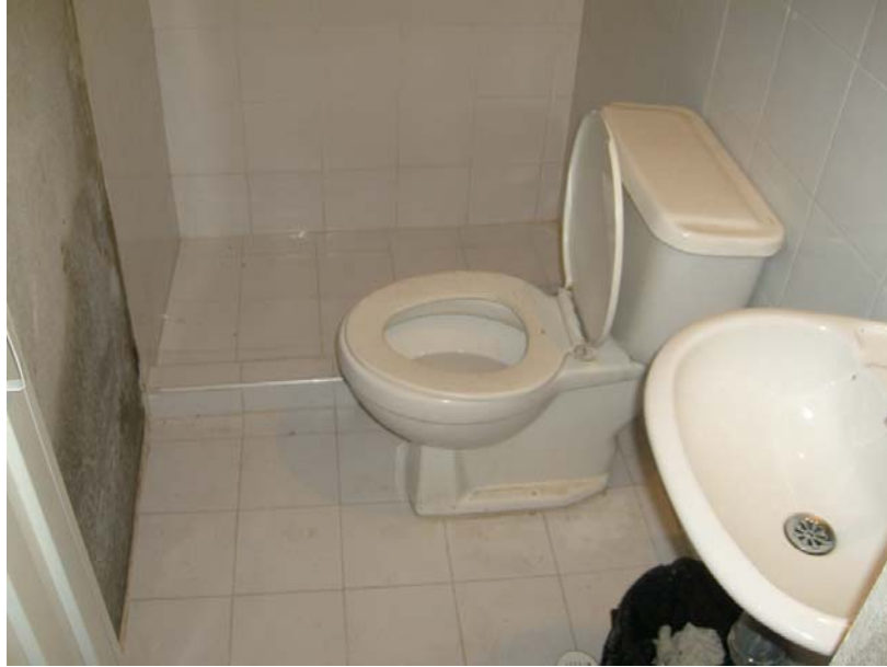
Foto 17. Realización de enchape 0.20x0.20 en muros y piso de baño
