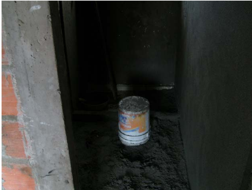
Foto 15. Realización de pañete impermeabilizado 1:3 en muros de baño
