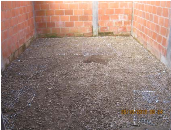
Foto 7. Colocación del refuerzo (tipo hojalata)
