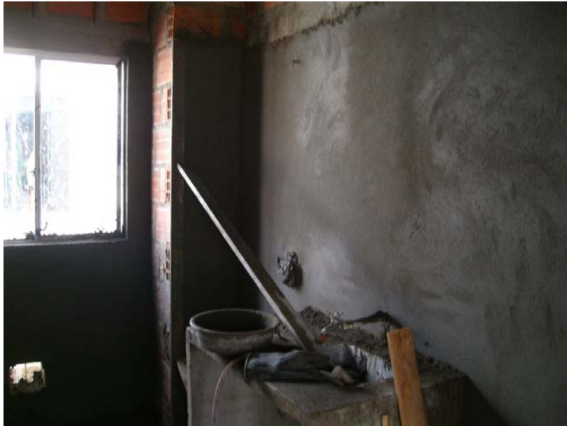
Foto 14. Realización de pañete impermeabilizado 1:3 en muros de cocina
