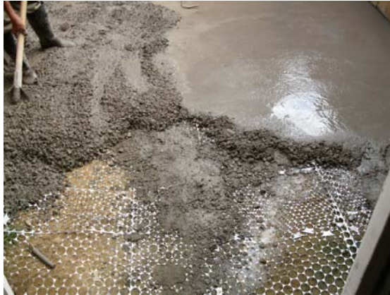
Foto 9. Construcción de la placa de piso en concreto
