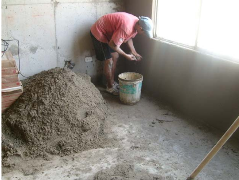
Foto 13. Realización de pañete 1:4 en muro de zona social
