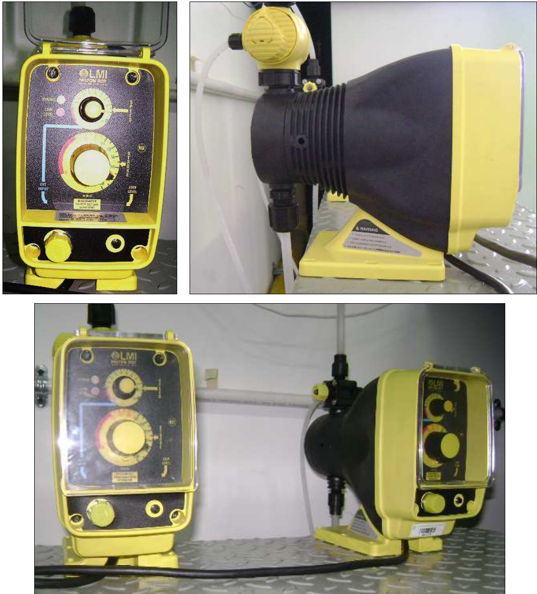
Figura B21. Bombas dosificadoras
