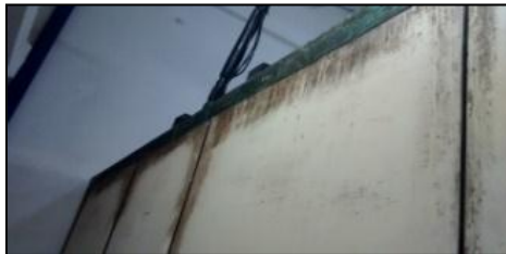
Figura 14. Paredes del cuarto frío de producto terminado
