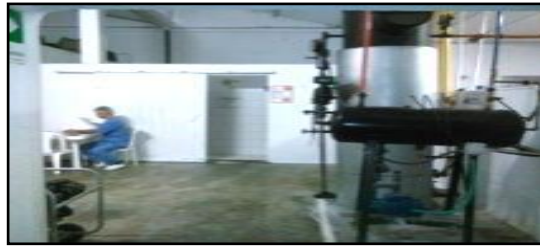
Figura 13. Zona de comedores del centro de producción
