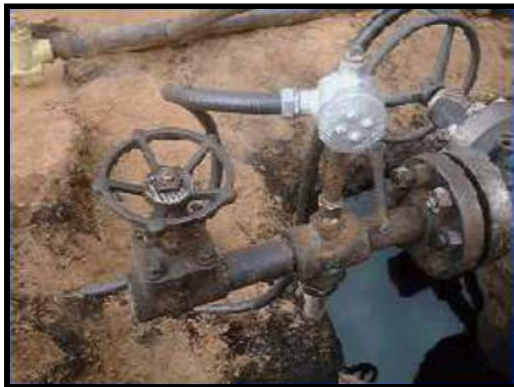
Figura16. Conexión del cable conductor al cabezal de pozo.
