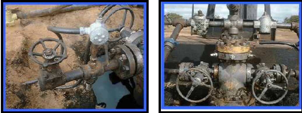
Figura 1c. Instalación eléctrica en cabeza de pozo. Fuente. www. Madis-eng.com
