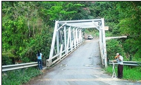
Figura 69. Detalle puente. Puente Vásquez.
