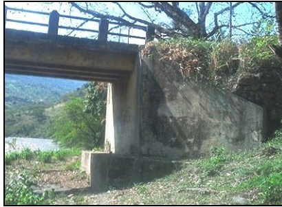
Figura 67. Detalle estribo. Puente Hernán Gómez Gómez.
