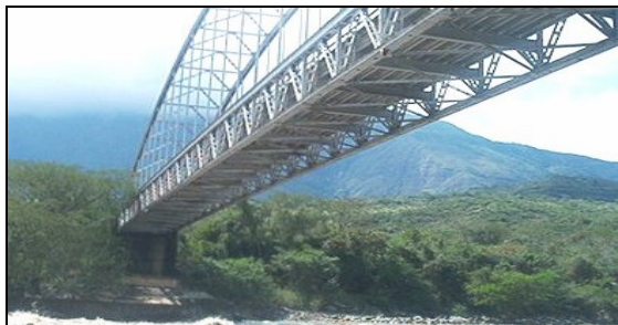
Figura 37. Detalle elevación 2. Puente Puntadero
