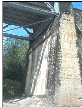
Figura 62. Detalle estribo. Puente Puntadero.
