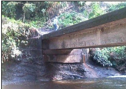
Figura 78. Detalle estribo - superestructura. Puente Guamacá.
