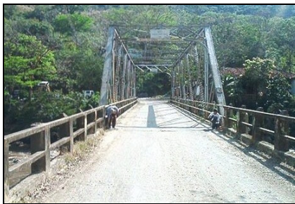
Figura 68. Detalle superficie de rodadura. Puente Hernán Gómez Gómez.
