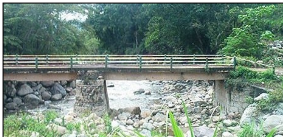
Figura 73. Detalle puente- superestructura. Puente Santa Rosa
