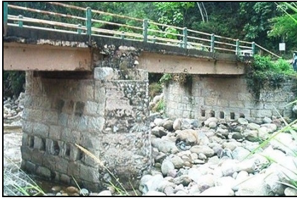
Figura 75. Detalle pila. Puente Santa Rosa
