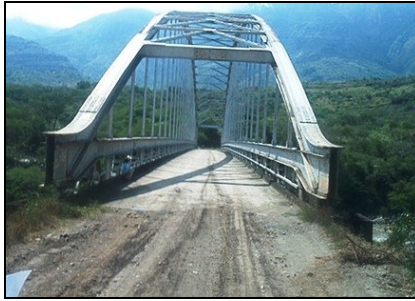
Figura 63. Detalle superficie de rodadura. Puente Puntiado.
