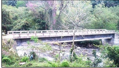
Figura 84. Detalle estribo. Puente Raisudo.
