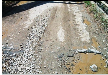
Figura 59. Detalle superficie de rodadura. Puente Gómez Niño.
