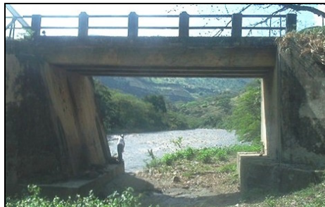
Figura 66. Detalle superestructura segunda parte. Puente Hernán Gómez Gómez.
