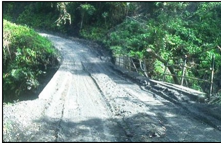
Figura 77. Detalle puente. Puente Guamacá.
