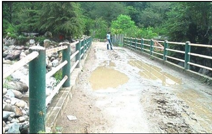
Figura 76. Detalle superficie de rodadura. Puente Santa Rosa
