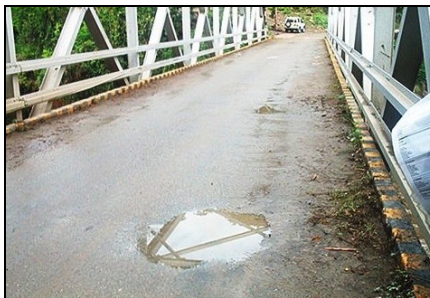
Figura 72. Detalle superficie de rodadura. Puente Vásquez.
