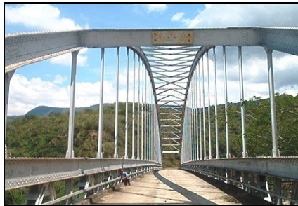
Figura 61. Detalle superestructura. Puente Puntadero.
