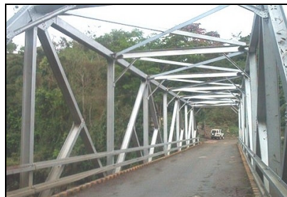
Figura 70. Detalle superestructura. Puente Vásquez.
